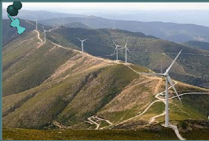
Fig. 2: Parque eólico na Serra do Açor, Portugal
