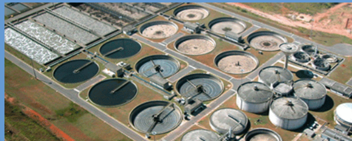
Estações de Tratamento de Esgotos Digestão anaeróbica
