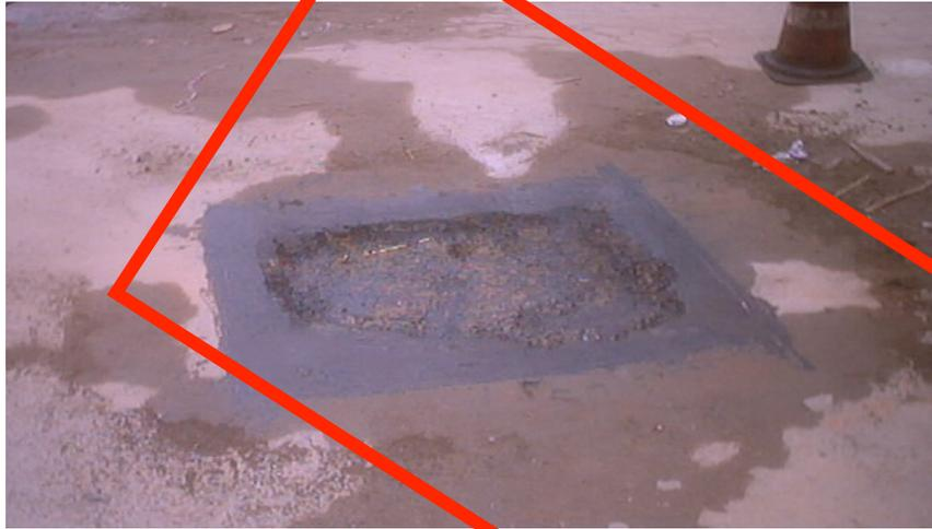
Imprimação com uso de regador - Tipo irregular de equipamento aspersor
