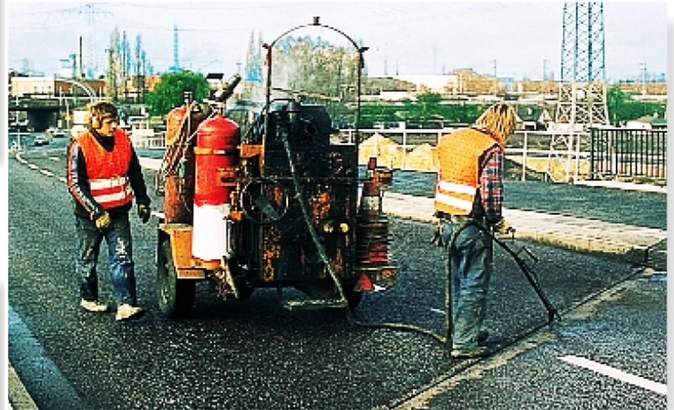
Preenchendo as juntas com material asfáltico especial
