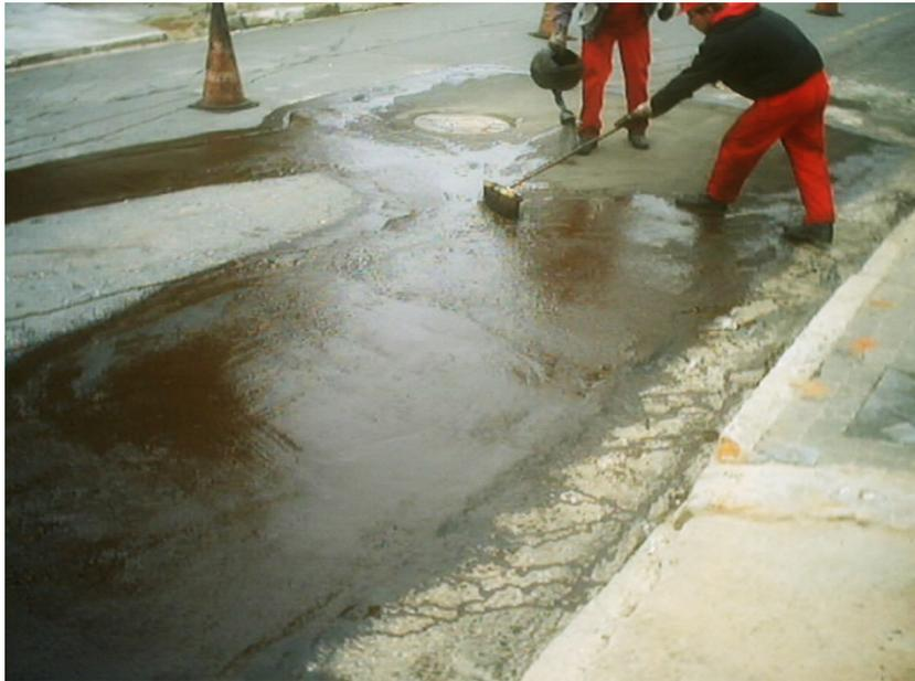
Deve-se aplicar imprimação ligante (cola) com o auxílio de um recipiente, por exemplo, regador com chuveiro (foto 76), iniciando pelas bordas e proporcionando o espalhamento da imprimação por toda a superfície da base de pavimentação e bordas perpendiculares, numa taxa de 0,4 a 0,6 litro/m. (NTS 164: 2012 – Rev. 1 )
