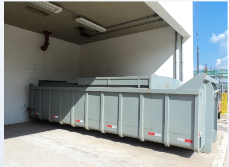
Caçamba de lodo
