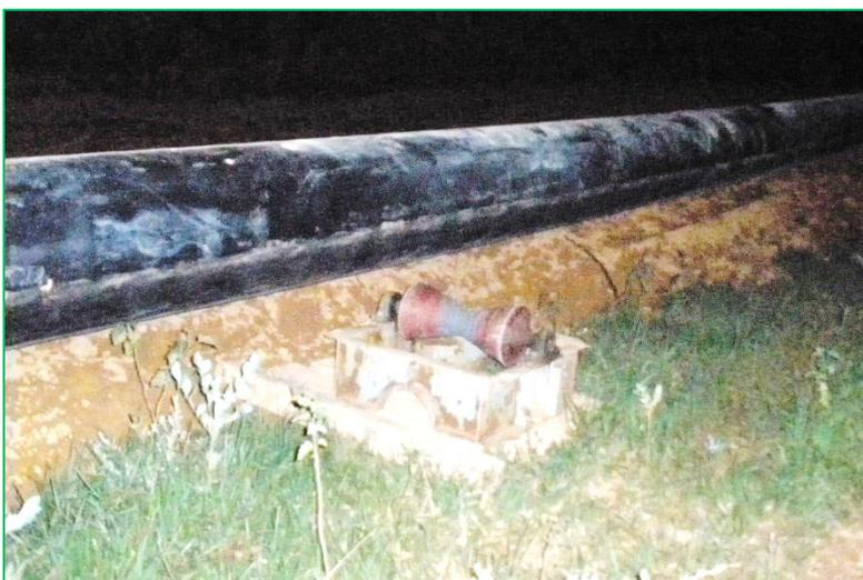
É possível reduzir drasticamente o esforço de puxamento na sonda utilizando técnicas de lastreamento da tubulação para contrabalancear o empuxo realizado pelo fluido de perfuração, diminuindo o atrito da tubulação com as paredes do furo e protegendo o seu revestimento.
