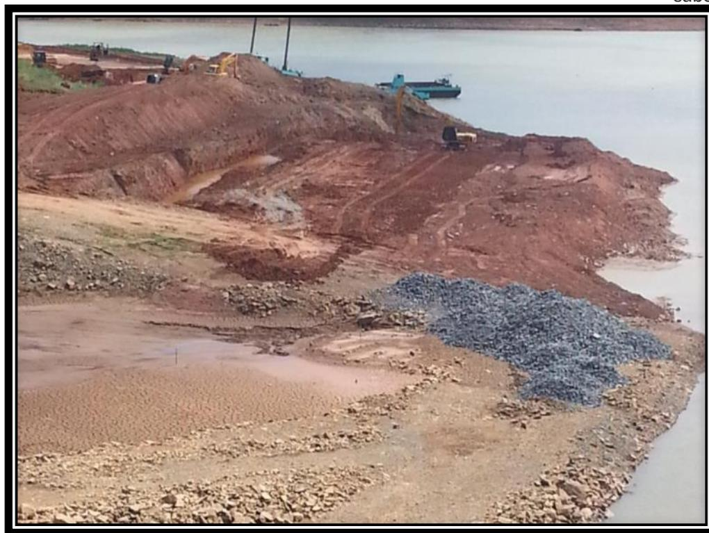
26/03/2014 - Escavação do canal de dissipação.
