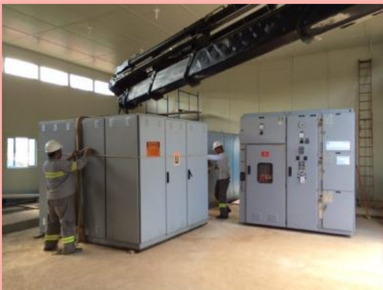
Painéis elétricos de média tensão
