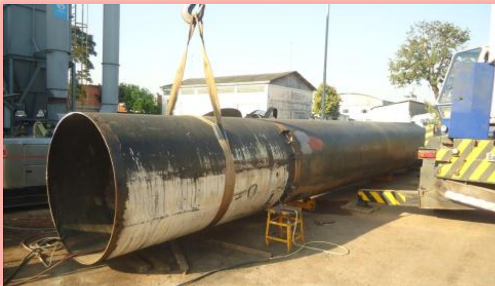
Parte superior da chaminé de equilíbrio – Tubulação com 12m de comprimento
