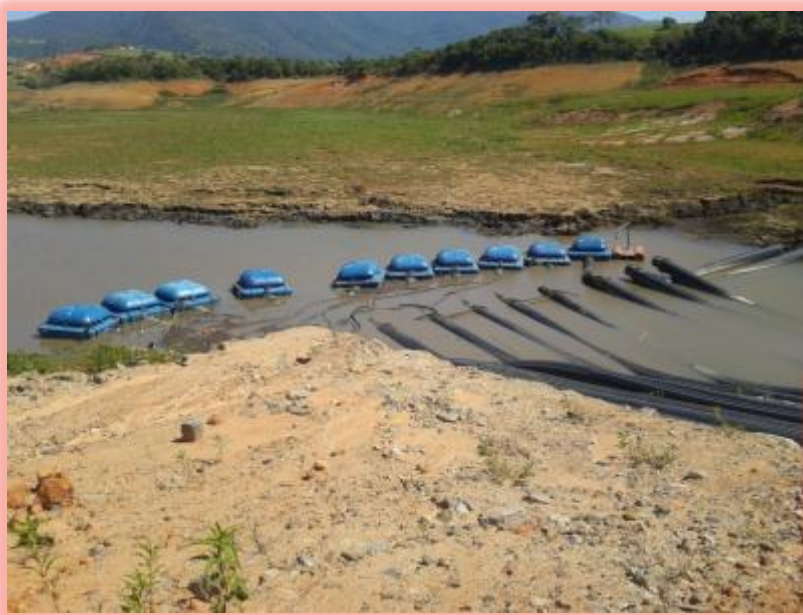
Motobombas flutuantes idênticas em funcionamento no Sistema Cantareira
