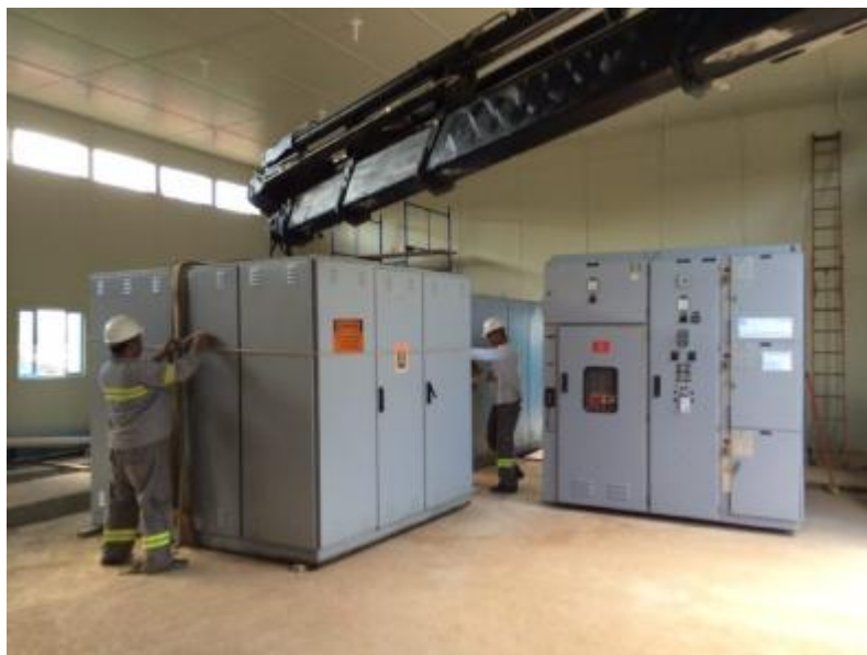
Inversores de frequência para acionamento dos motores das motobombas flutuantes
