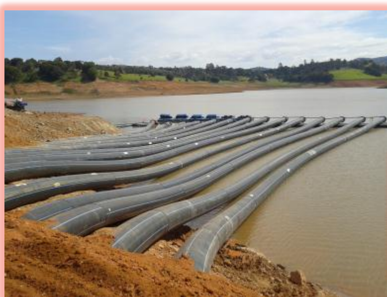
Tubulações com diâmetro 1000 mm utilizadas no Sistema Cantareira
