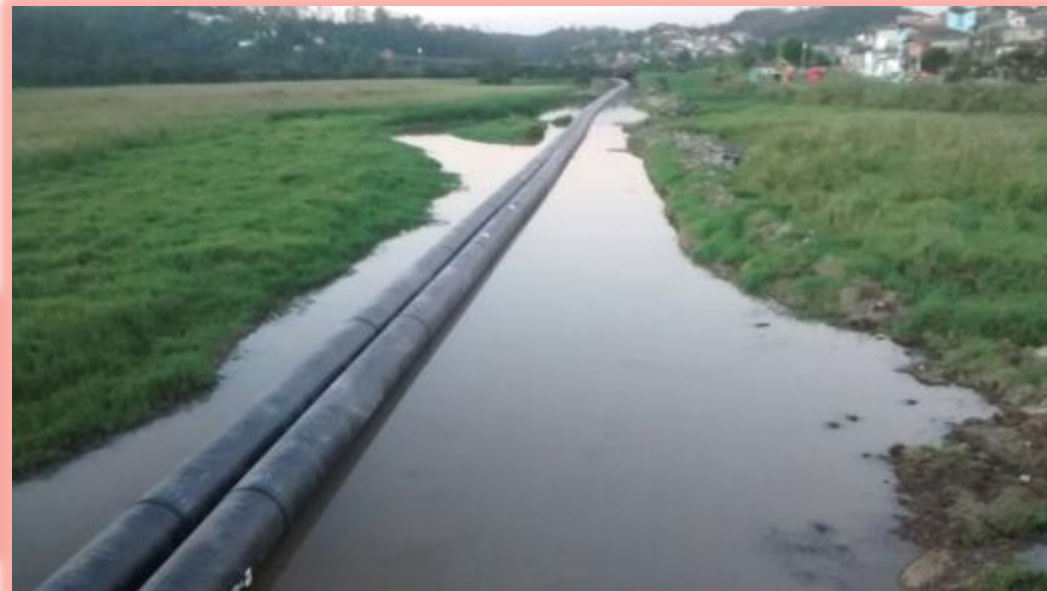
Lançamento de tubulações com diâmetro 1200 mm em Rio Grande da Serra
