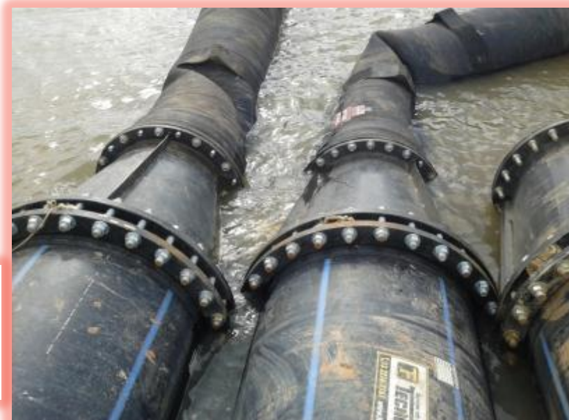
Detalhe de um acoplamento utilizando o sistema de colarinho + flange
