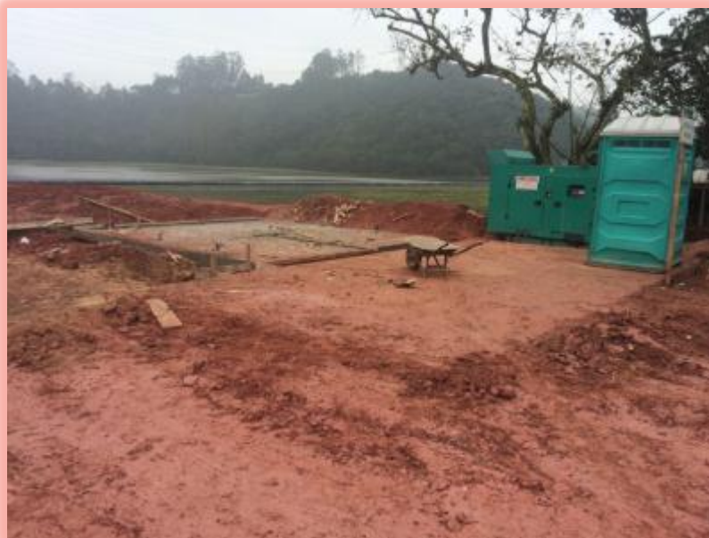
Bases de concreto preparadas para receber os RHOs e a sala de compressores
