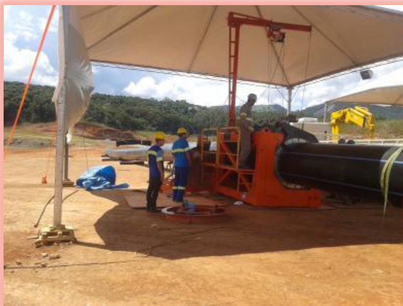
Execução de soldagem de tubos de PEAD pelo processo de termofusão
