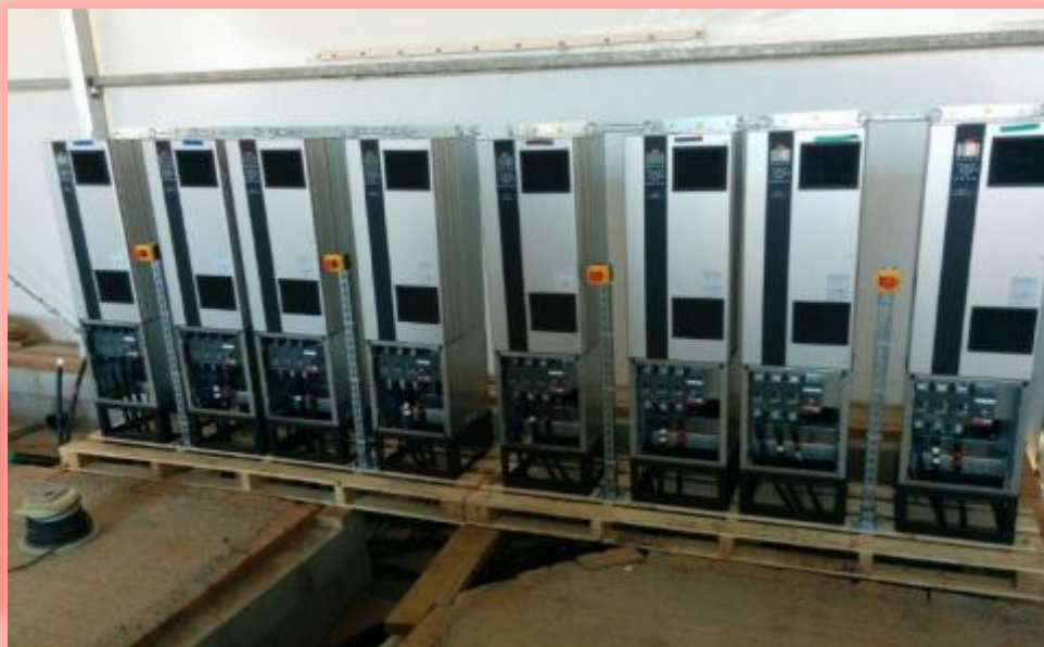
Inversores de frequência para acionamento dos motores das motobombas flutuantes
