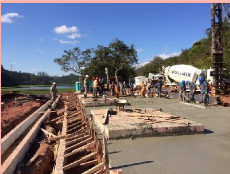
Preparação das bases de concreto que receberão os conjuntos motobombas
