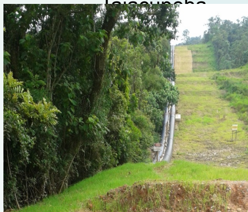
Bombeamento de até 4 \text{ m}^3/\text{s} do Rio Grande para a represa Taiacuaba
