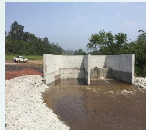
Bombeamento de até 4 \text{ m}^3/\text{s} do Rio Grande para a represa Taiacuaba
