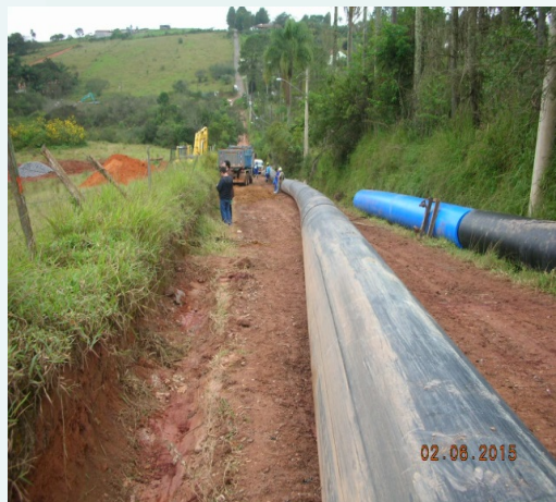
Bombeamento de 1,0 \text{ m}^3/\text{s} do Rio Guaió para o Represa Taiacuaba
