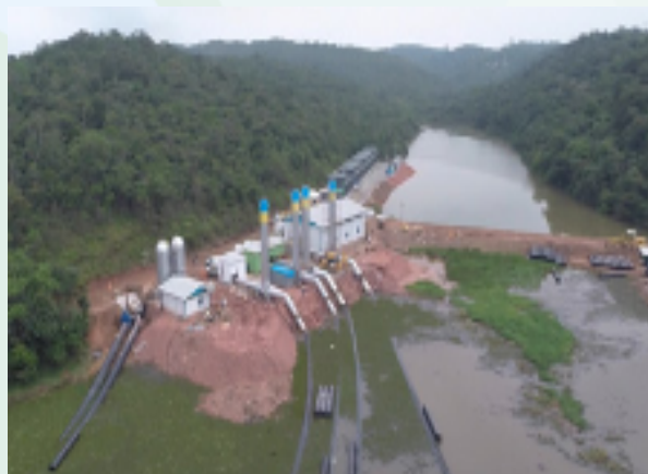
Bombeamento de até 4 \text{ m}^3/\text{s} do Rio Grande para a represa Taiacuaba
