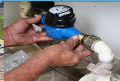
Instalação de hidrômetros (Salto) - Foto: Josevane Victor
