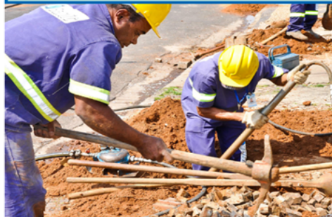
Troca de rede de água (Rio Claro) - Foto: Pref. de Rio Claro
