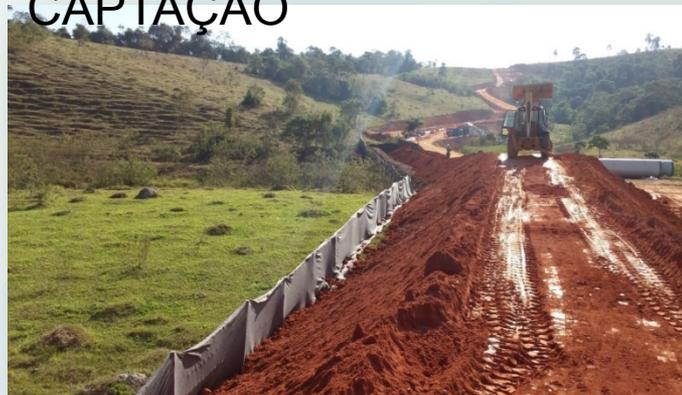
CONTENÇÃO DE SOLO COM MANTA GEOTÊXTIL
