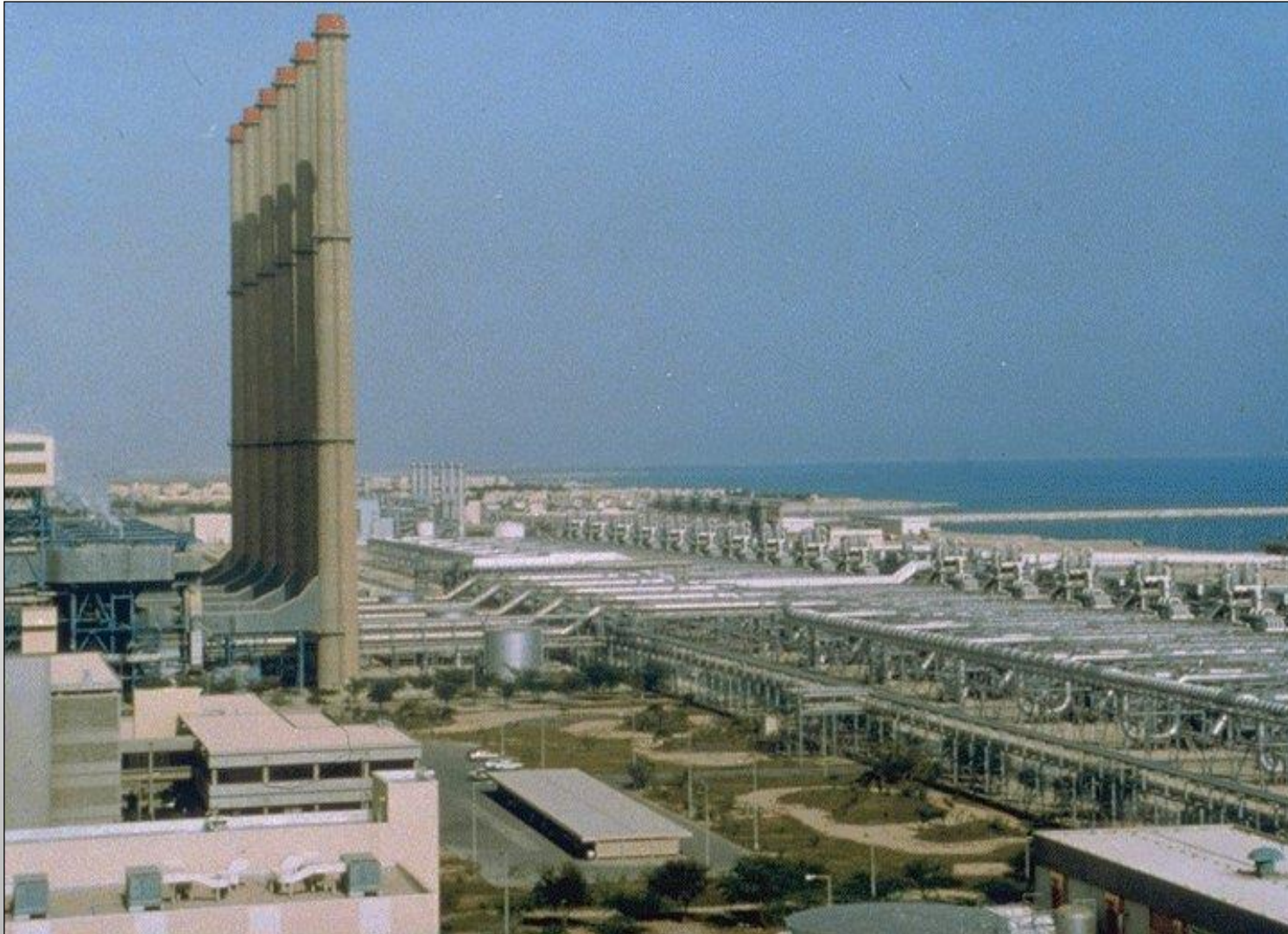
Usina de dessalinização em Jubail (Arábia Saudita)
