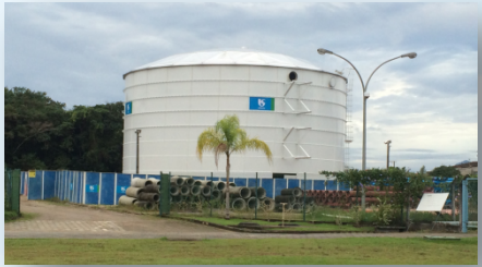
Reservatório Porto Novo Município de Caraguatatuba Metálico Cap. 5.000m 3
