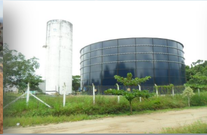
Reservatório Indaiá Município de Bertioga Metálico Cap. 3.000m 3
