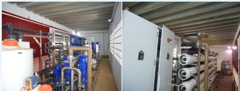
Cesário Lange RM Remoção de Flúor por Osmose reversa
