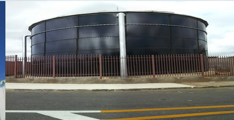
Reservatório Jardim Colonial Município de São José dos Campos Metálico Cap. 1.030m 3
