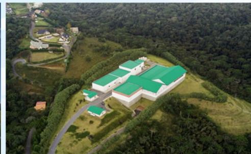
ETE Campos do Jordão Eficiência: 98% - Membrana filtrante (Ultrafiltração) Remoção de nutrientes e turbidez menor que 0,2
