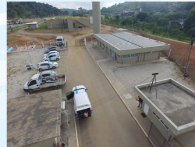
ETE Santa Isabel Q = 140 l/s - Tratamento Terciário
