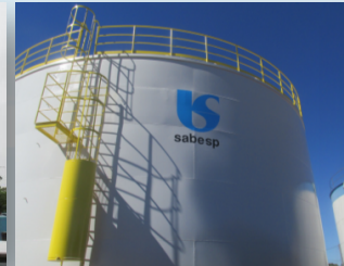
Reservatório Itararé Metálico Cap. 1.500m 3
