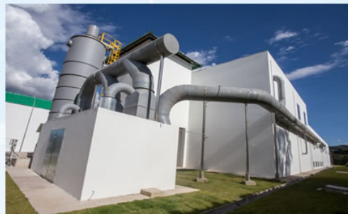
ETE Campos do Jordão Eficiência: 98% - Membrana filtrante (Ultrafiltração) Remoção de nutrientes e turbidez menor que 0,2
