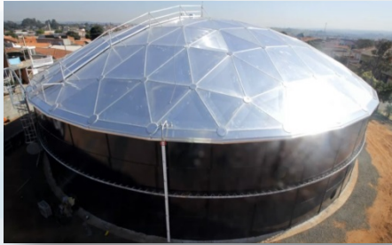
Reservatório Jd. Amanda Município de Hortolândia Metálico Cap. 5.000m 3
