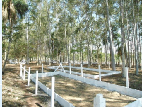
Valas de Infiltração Plantio de eucaliptos em 1,3 ha 1.00 m 2 de área de infiltração
