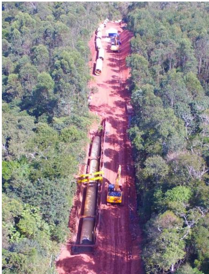
adutora de água bruta \phi 2.100 mm, L = 49,3 km
