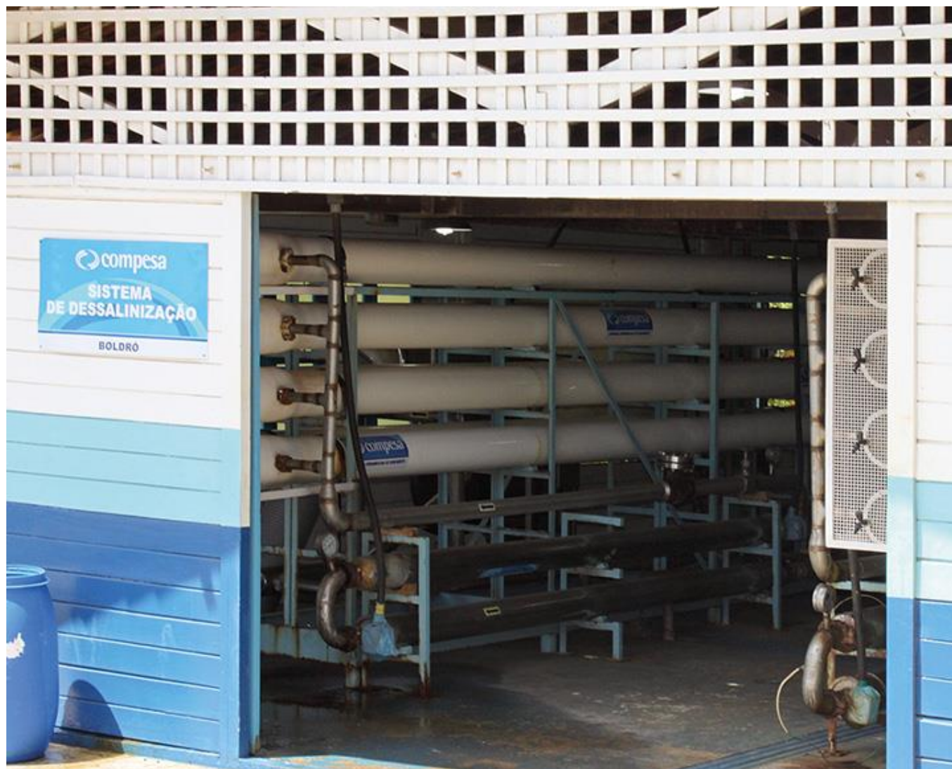
ESTAÇÃO DE TRATAMENTO - OR
