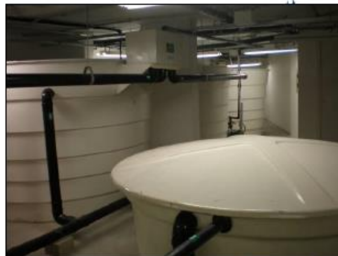
Figura 2 – Vista Geral da ETAC
