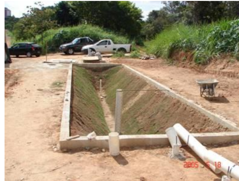
Vala de detenção
