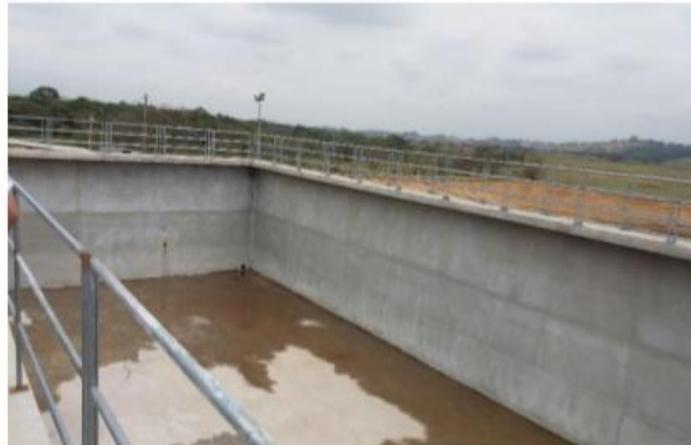
Foto 4 – Tanque Aeróbio de Lodo
