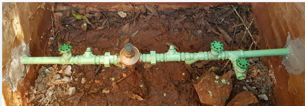
Válvula redutora de pressão
