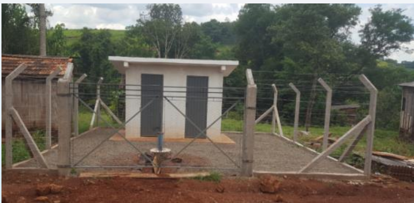
Casa de Tratamento
