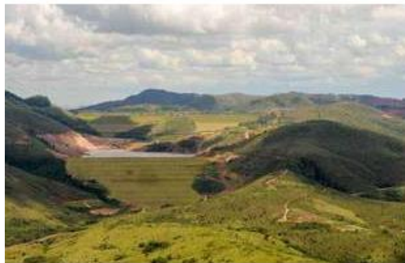
As três barragens de Forquilha, em Ouro Preto,
