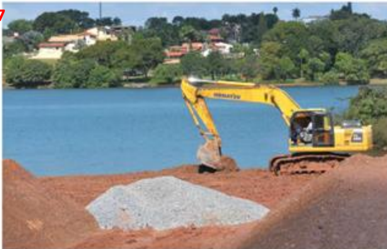
Máquinas começam obra emergencial de captação de água no Lago Paranoá, em Brasília — Foto: Tony Winston/GDF/Divulgação
