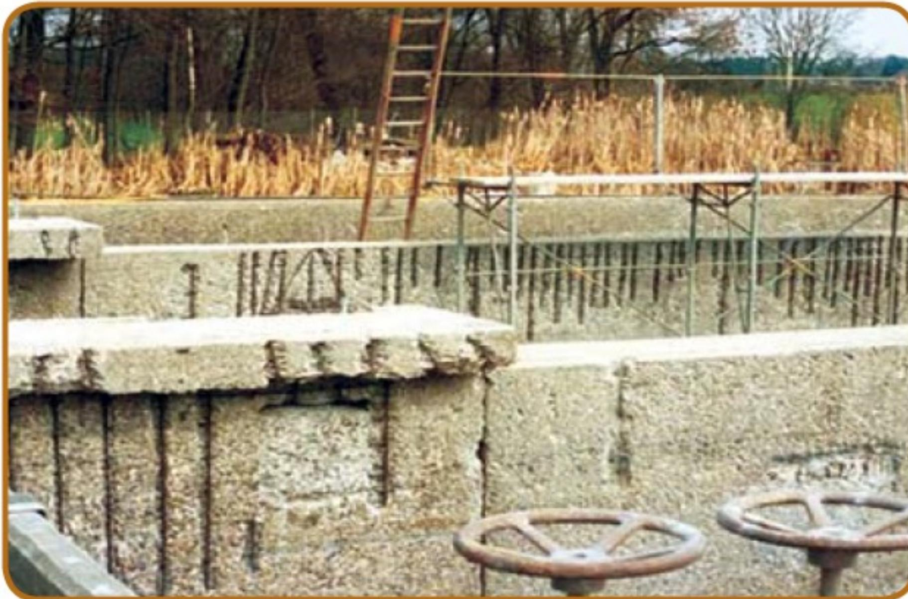
**Figura 3 – Ataque de ácido sulfúrico biogênico**
