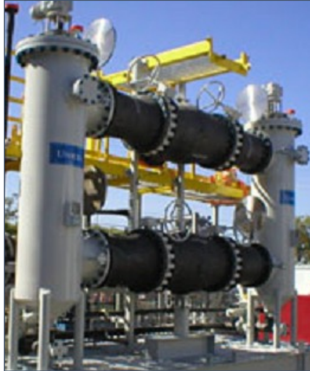
Filtros automáticos com pintura especial interna e externa para evitar corrosão pela água do mar. Possui eixo Monel e vedação mecânica. Localização: Estados Unidos
