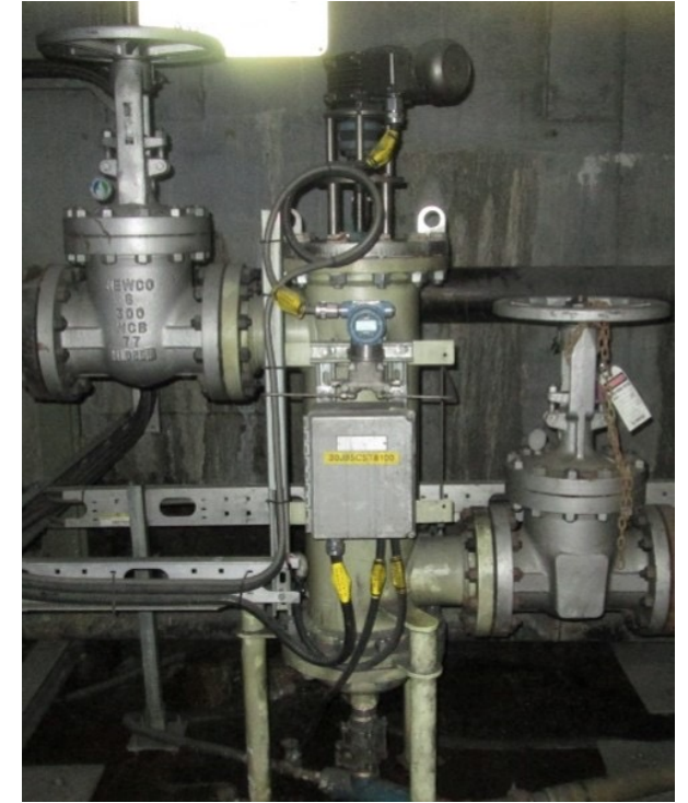
Mina Goldcorp Musselwhite – Filtro utilizado no processo de Desidratação. Localização: Canadá
