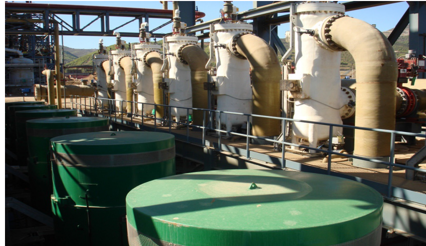
Filtros de fibra de vidro usados na dessalinização da água do mar. Localização: Argélia
