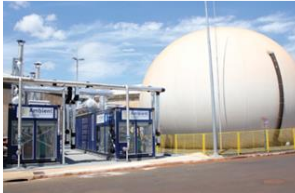
Sistema de produção de Biometano como combustível veicular - ETE Franca – RG – Pardo e Grande
