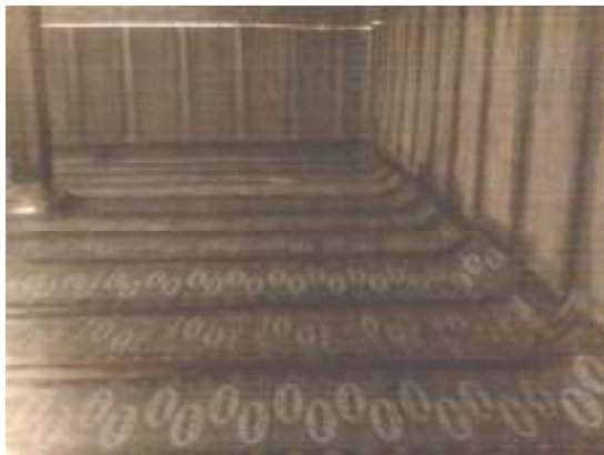
Foto 3 – Vista da área impermeabilizada
