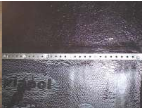
Foto 4 – Detalhe de fixação mecânica da manta
