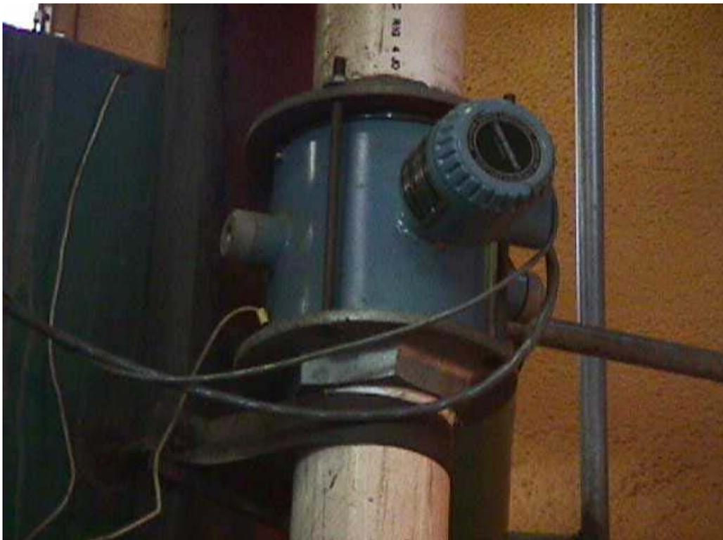
**Figura 2: Vista do medidor eletromagnético.**
