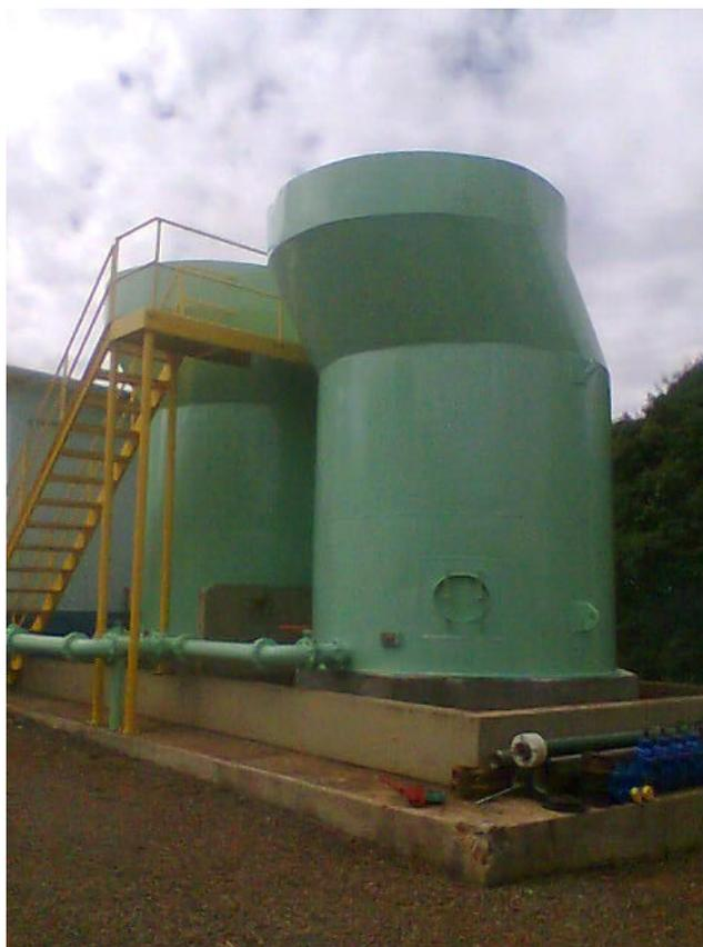
**Figura 07:** Módulos de floco-decantação instalados para o aumento da Capacidade de Tratamento da ETA Rio Pato Branco.
