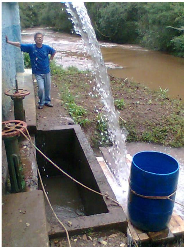
**Figura 05:** Medição de vazão, utilizando bombona, do extravasor da câmara de sucção do Alto Recalque da Captação Rio Pato Branco.
