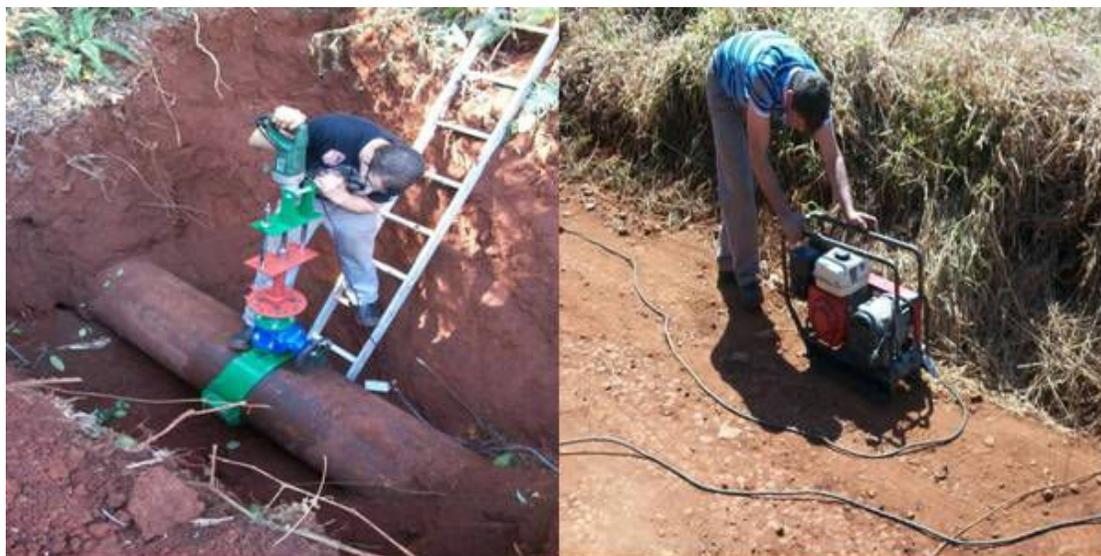
**Figura 09:** Execução de furação de tubulação em carga para implantação de 12 ventosas na AAB Rio Pato Branco.
