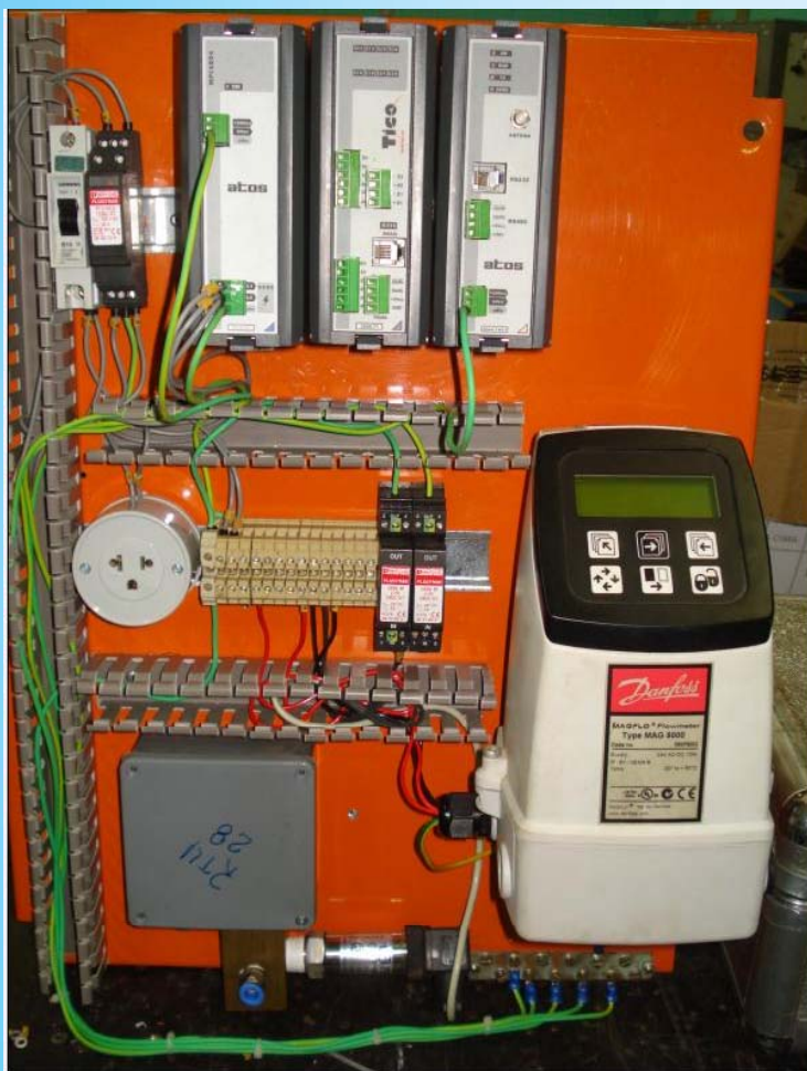
PROJETO ADEQUADO PARA NOVO SCOA
