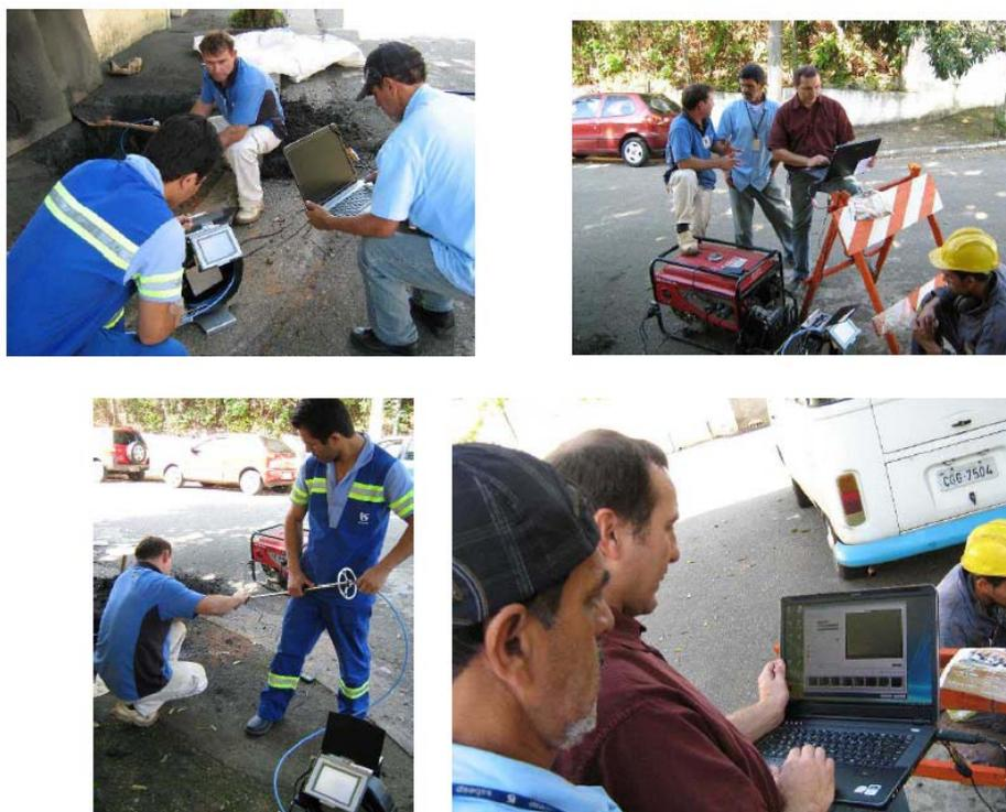
**Figura 11: Inspeção televisiva da rede o término da limpeza da tubulação.**
