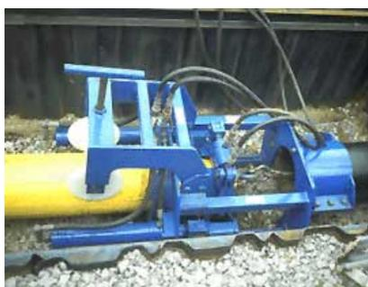
**Figura 8: Inserção por Swagelining.**
