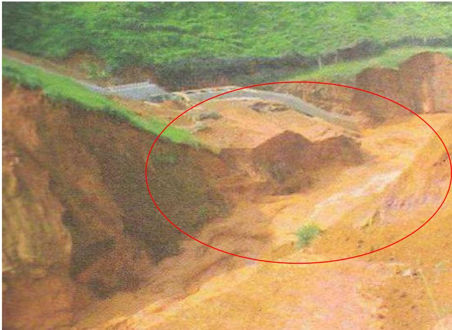
**Foto 5: Brecha originada na ruptura da Barragem de Rejeitos São Francisco**
