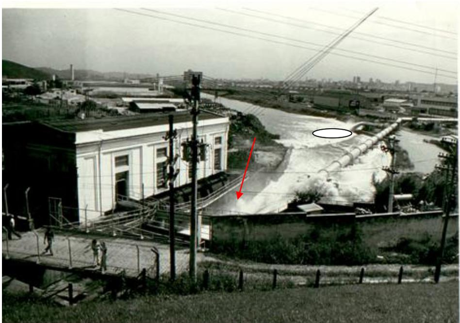
**Foto 3: Saída do descarregador de fundo - Barragem Guarapiranga**
