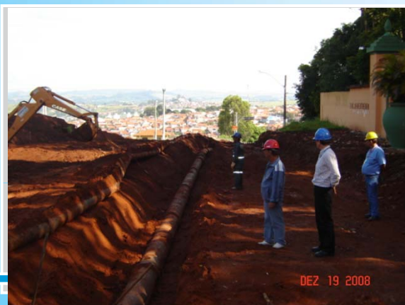
Remanejamentos de Redes Críticas
