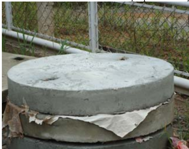
Figura 5 – Laje de fundo
