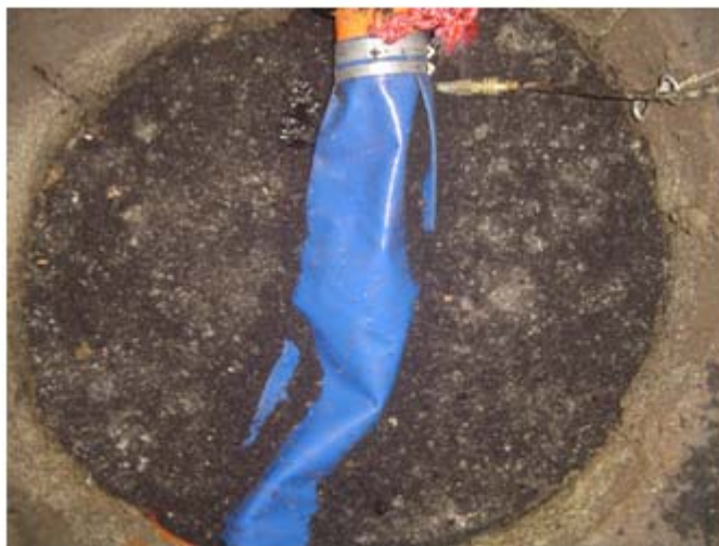
Figura 11 - Fundo sendo moldado em material betuminoso
