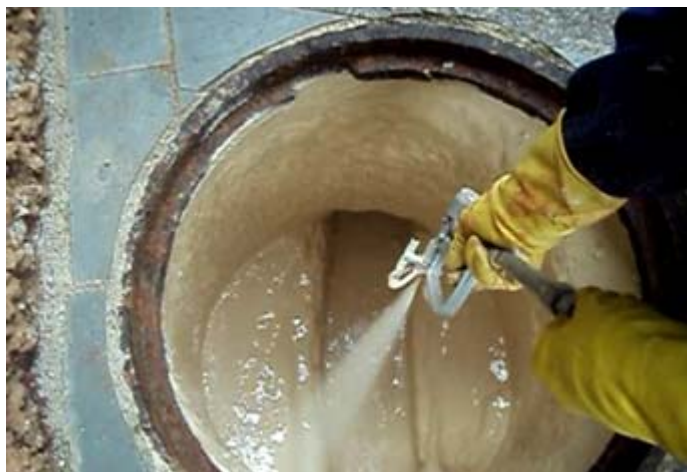
Figura 13 - Aplicação da tinta PU
