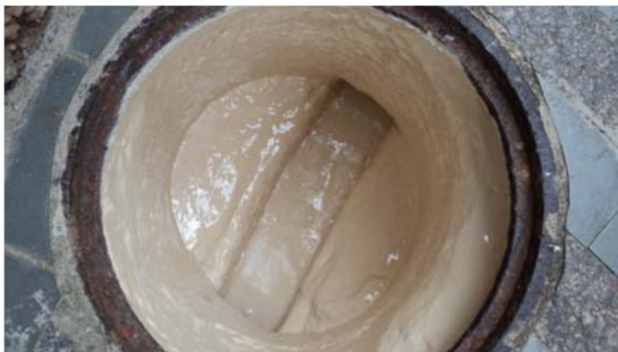
Figura 12 - Poço visita após aplicação da tinta PU
