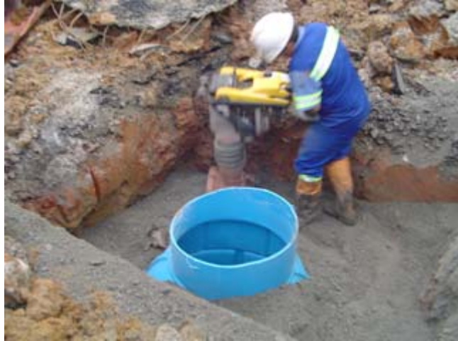
Figura 19 - Compactação sendo executada
