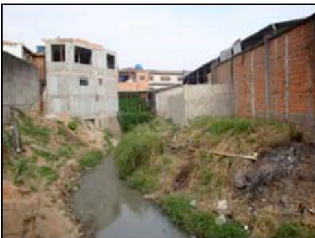
Vista dos fundos da faixa invadida
