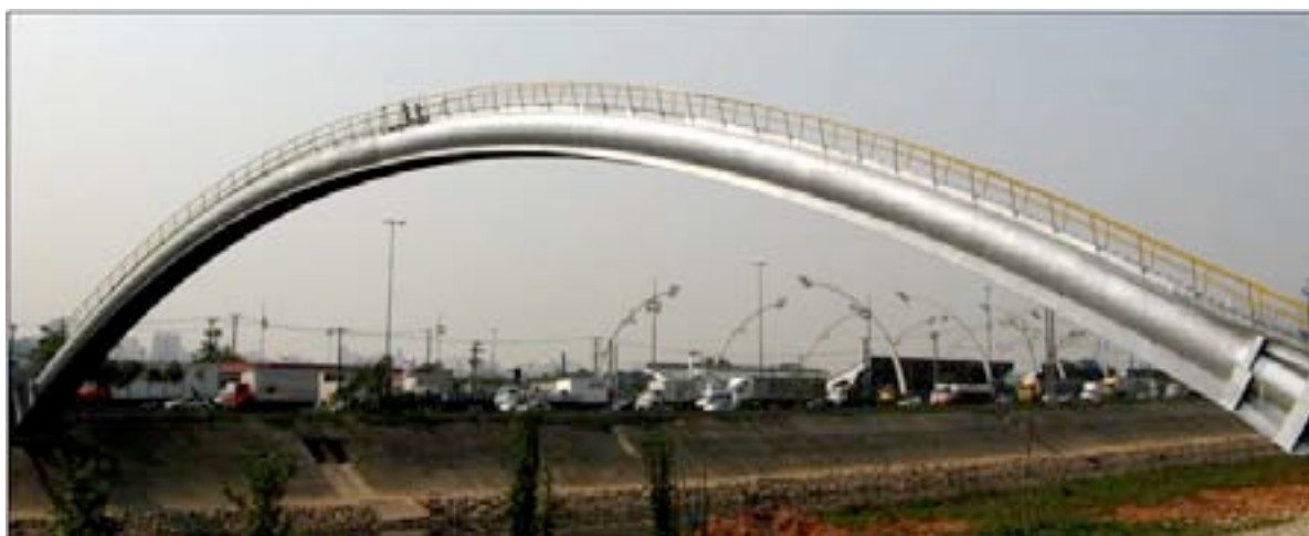
Figura 3: Travessia aérea da Adutora Guaraú - Consolação sobre o Rio Tietê
