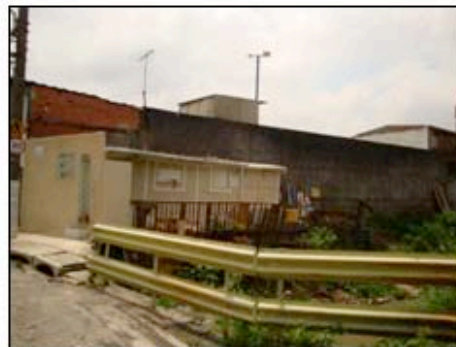
Vista da lateral da faixa invadida
