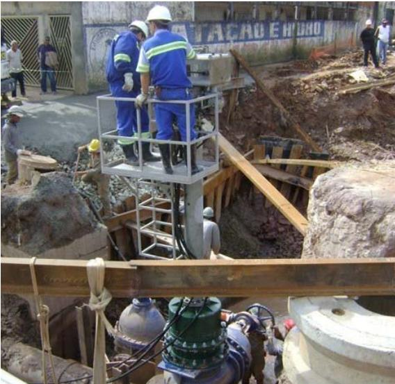
9 – Execução do furo em carga DN 600 para instalação do equipamento de bloqueio no 1º ponto de interligação
