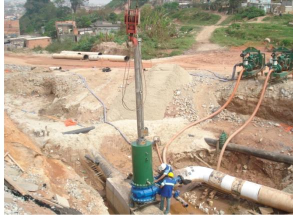
8 – Detalhe da instalação da máquina de bloqueio em carga no 1º ponto do novo trecho remanejado
