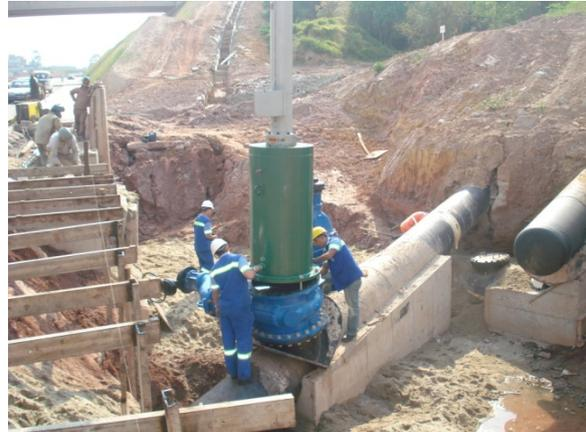
10 – Detalhe da instalação da máquina de bloqueio em carga no 2º ponto do novo trecho remanejado
