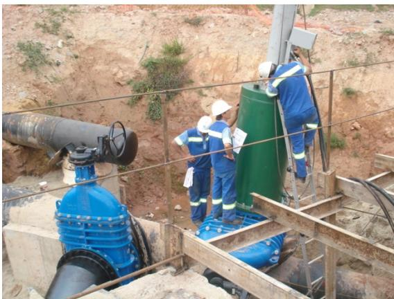
11 – Cabeçote de bloqueio inserido na tubulação no 2º ponto de interligação
