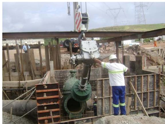
4 – Detalhe da instalação da máquina de furação em carga para execução do 2º furo de interligação
