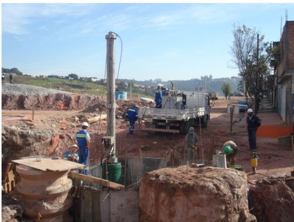
15 – Cabeçote de bloqueio DN 600 inserido na tubulação, no 1º ponto de interligação
