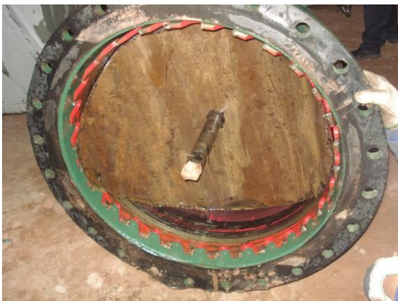
13 – Detalhe da “bolacha” DN 800 cortada da adutora, confirmando a execução do furo
