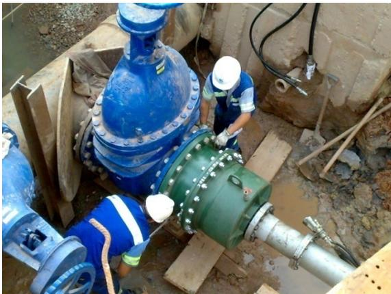
1 – Detalhe da instalação da máquina de furação em carga para execução do 1º furo de interligação
