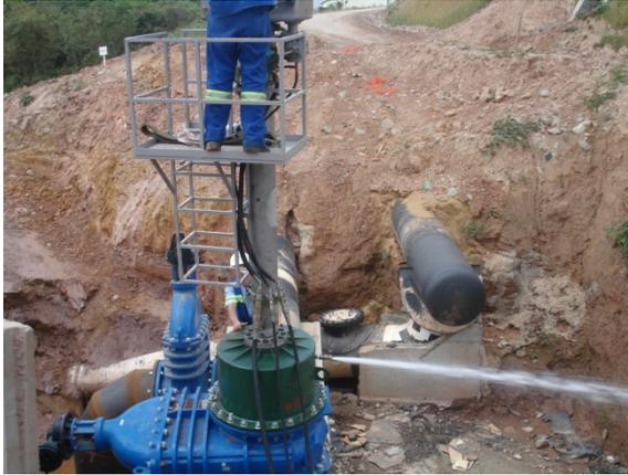
7 – Execução do furo em carga para instalação do equipamento de bloqueio no 2º ponto de interligação
