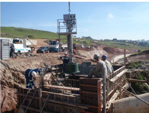
11 – Detalhe da instalação da máquina de furação em carga para execução do 2º furo de bloqueio
