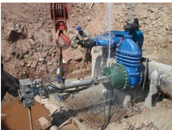
4 – Execução do furo em carga para interligação do 1º ponto do novo trecho de tubulação
