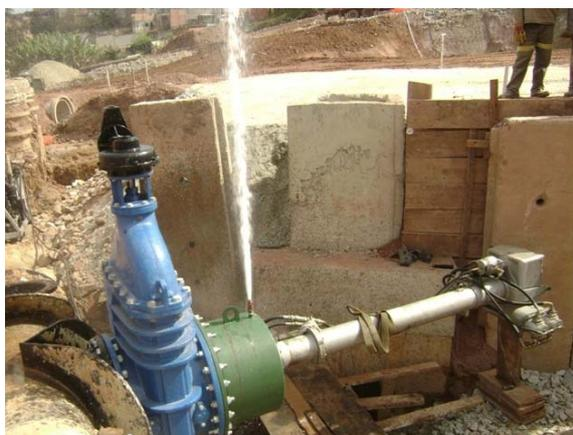
5 – Execução do furo em carga para interligação do 2º ponto do novo trecho de tubulação
