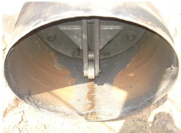
12 – Vista interna da adutora bloqueada, possibilitando a desativação do trecho interferente com a obra
