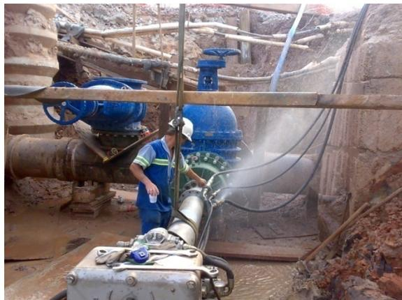
2 – Execução do furo em carga DN 600 para interligação do 1º ponto do novo trecho de tubulação
