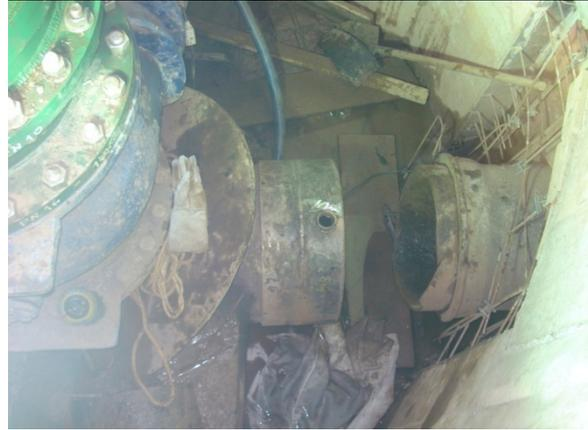
20 – Detalhe da tubulação capeada no 1º ponto de interligação
