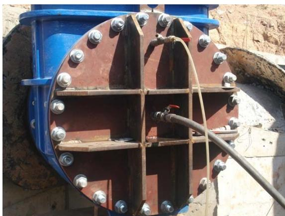
3 – Instalação do flange cego e execução do teste de estanqueidade do conjunto válvula e derivação flangeada
