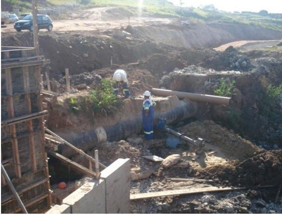
7 – Execução do furo DN100 para descarga da linha
