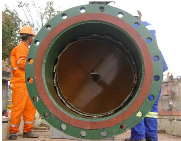
10 – Detalhe da “bolacha” DN 600 cortada da adutora, confirmando a execução do furo
