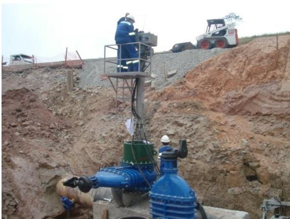
6 – Execução do furo em carga para instalação do equipamento de bloqueio no 1º ponto de interligação
