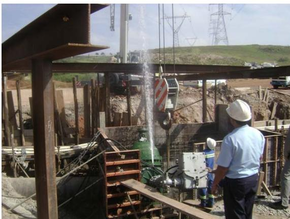
5 – Execução do furo em carga DN 800 para interligação do 2º ponto do novo trecho de tubulação
