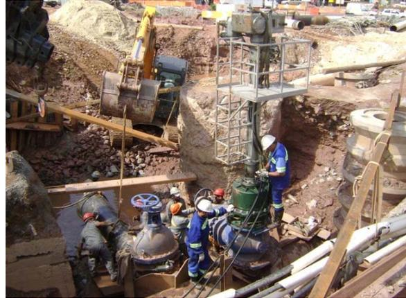
8 – Detalhe da instalação da máquina de furação em carga para execução do 1º furo de bloqueio
