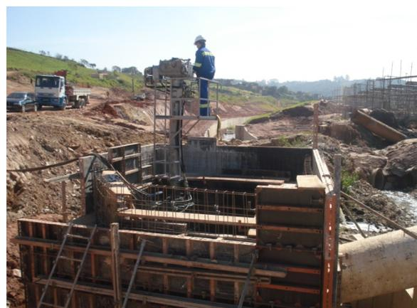
12 – Execução do furo em carga DN 800 para instalação do equipamento de bloqueio no 2º ponto de interligação
