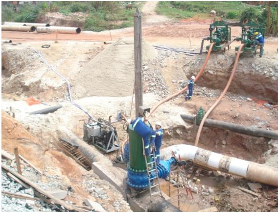
9 – Cabeçote de bloqueio inserido na tubulação no 1º ponto de interligação
