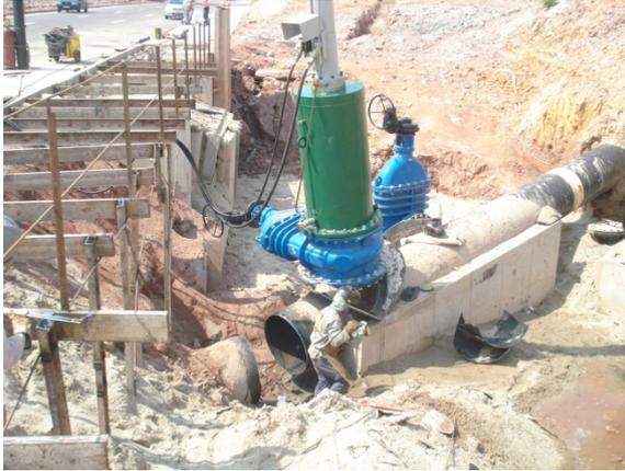
13 – Corte da adutora para instalação do capeamento e desativação do trecho antigo no 2º ponto
