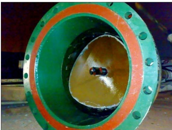
3 – Detalhe da “bolacha” DN 600 cortada da adutora, confirmando a execução do furo
