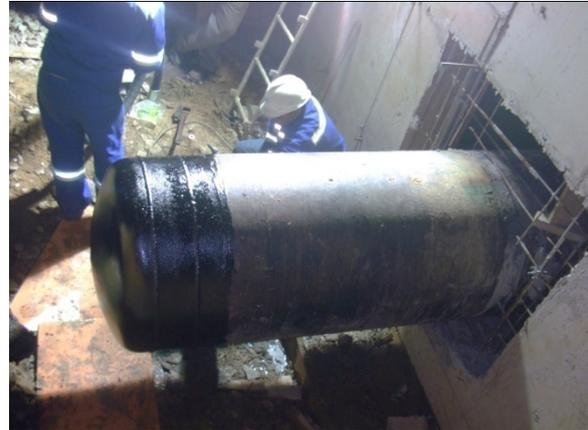
22 – Detalhe da tubulação capeada no 2º ponto de interligação
