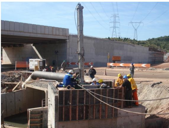
16 – Cabeçote de bloqueio DN 800 inserido na tubulação, no 2º ponto de interligação
