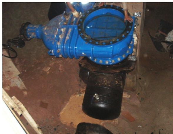
18 – Detalhe da tubulação capeada no 2º ponto de interligação
