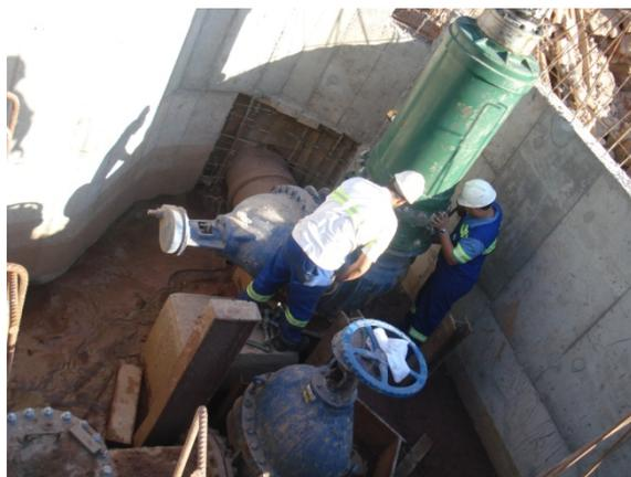
14 – Detalhe da instalação da máquina de bloqueio em carga
