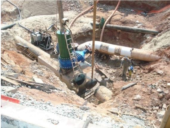
15 – Corte da adutora para instalação do capeamento e desativação do trecho antigo no 1º ponto
