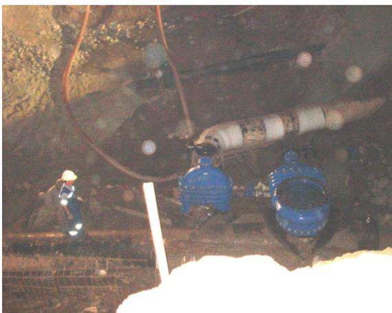
17 – Detalhe da tubulação capeada no 1º ponto de interligação
