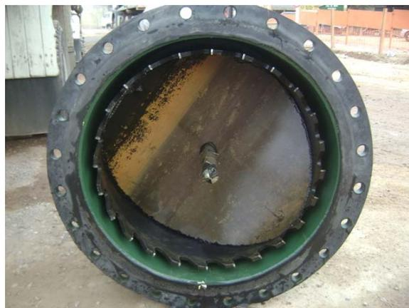
6 – Detalhe da “bolacha” DN 800 cortada da adutora, confirmando a execução do furo
