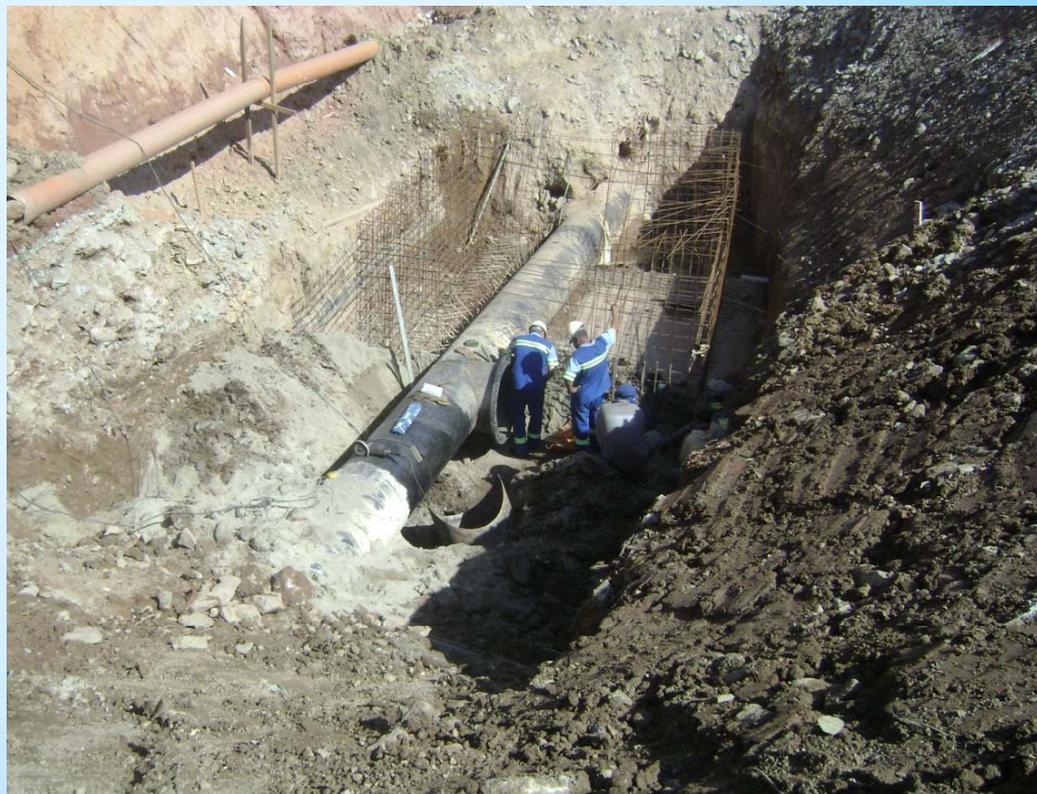
○ Instalação de válvulas de bloqueio (tipo gaveta) e realização de testes de estanqueidade
