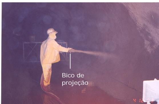
**Figura 9 – Projeção de concreto no túnel**
