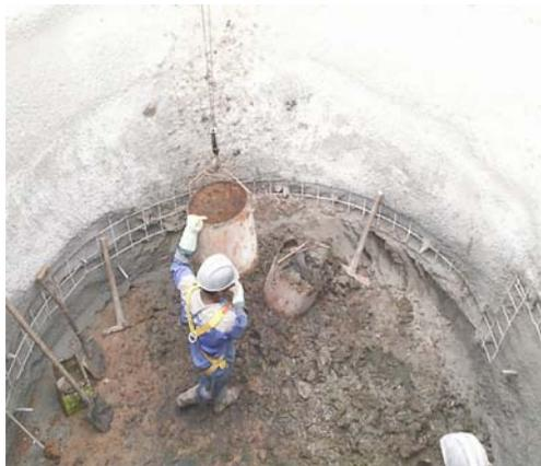
Utilizando-se o concreto projetado, são escavados trechos com profundidade máxima de 1,00m (dependendo das condições do solo), em seguida é fixada armação de aço e projetado concreto para a estruturação do PS.
