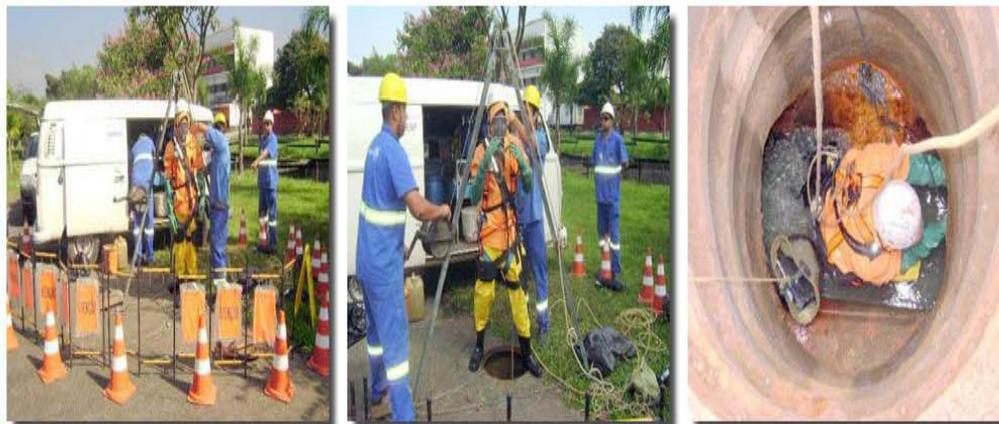
Na última terça-feira, dia 11/05, foram instalados dois medidores de vazão no Coletor Tronco Aterrado - Córrego Aterrado/Zavuvus. A ideia da instalação surgiu em um benchmarking realizado pela Divisão de Operação de Esgotos - MSEE na Unidade de Negócio Leste - ML, onde existe um contrato para instalação de medidores de vazão em diversos pontos, principalmente nos córregos que estão sendo despoluídos pelo Programa Córrego Limpo.
