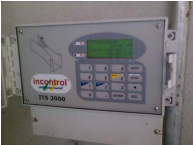
Foto 5 Medidor de vazão secundário onde ocorre a transformação matemática da vazão
