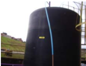
Foto 1: Reservatório 02 de Água de Reúso escolhido para o teste, capacidade 25000 litros.
