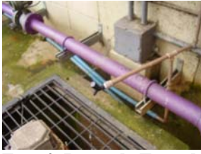
Foto 4: Ponto de Tomada de Amostra pós Lâmpada UV.
