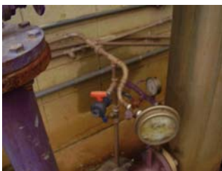
foto 8: Ponto de alimentação do teste interligação do sistema de recirculação e ponto de tomada de amostra, antes da Lâmpada UV, Manômetro de pressão do sistema (menor divisão 0,10 bar).
