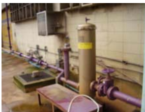
foto 6: Sistema de Filtro Cartucho de 1 micron nominal.
