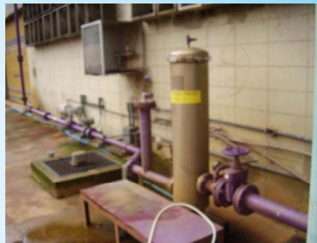
Foto 06: Sistema de filtro cartucho 1µm nominal
