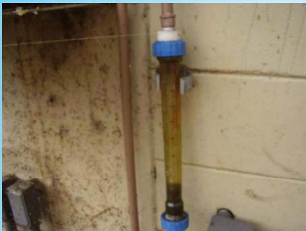
Foto 05: Rotômetro para medição de vazão antes da lâmpada UV
