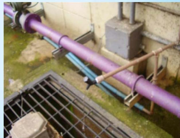
Foto 04: Ponto de tomada de amostra após a lâmpada UV
