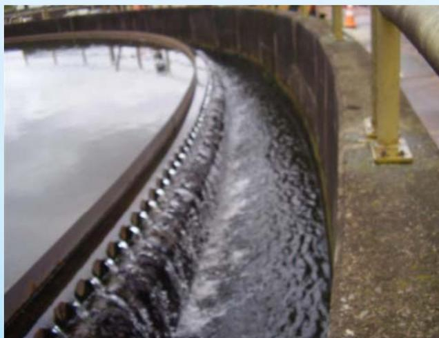
Foto 11: Vertedores dos decantadores secundários (coleta do efluente final).
