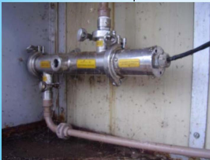
Foto 07: Dispositivo com lâmpada UV
