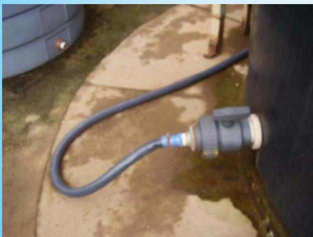
Foto 03: Tomada de sucção do sistema de recirculação
