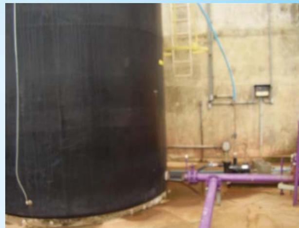
Foto 02: Sistema de retorno com bomba de recirculação e mangueira de nível
