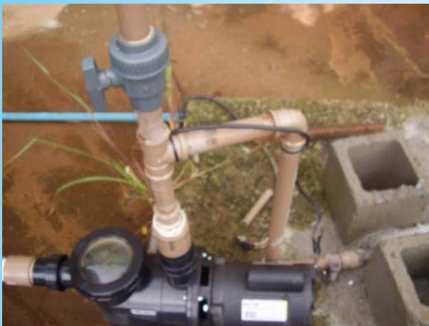
Foto 09: Bomba de recirculação e sistema de retorno p/ ajuste da vazão
