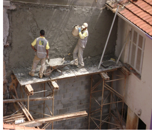
Figura 17 –Muro de Alvenaria
