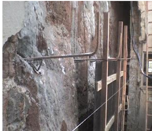
Figura 13 - Instalação dos grampos e drenos (vista lateral)
