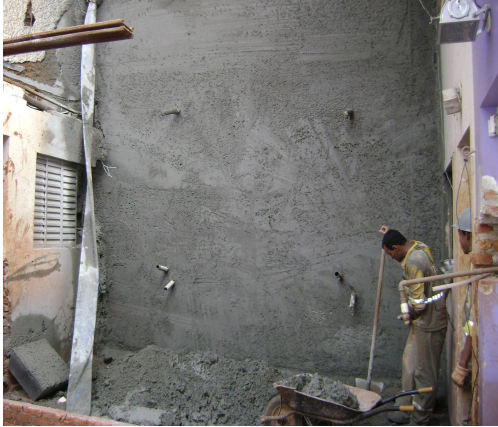
Figura 18 – conclusão do concreto projetado
