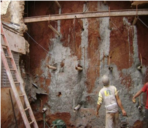
Figura 12 - Instalação dos grampos e drenos (vista frontal)
