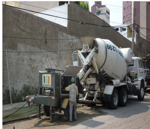
Figura 15 - caminhão responsável pela projeção de concreto
