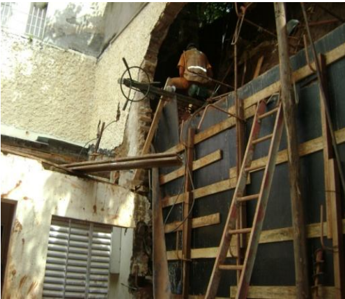
Figura 14 - Forma para preenchimento de solo cimento
