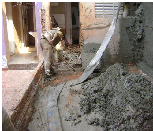
Figura 17 - limpeza após projeção de concreto
