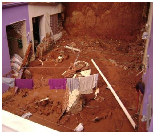
Figura 5 – Soterramento dos imóveis
