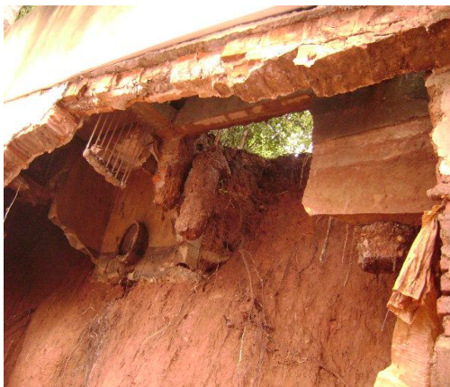
Figura 2 – talude erodido
