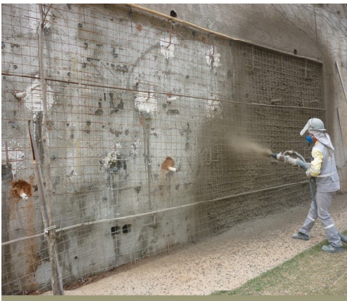
Figura 16 - Projeção de Concreto
