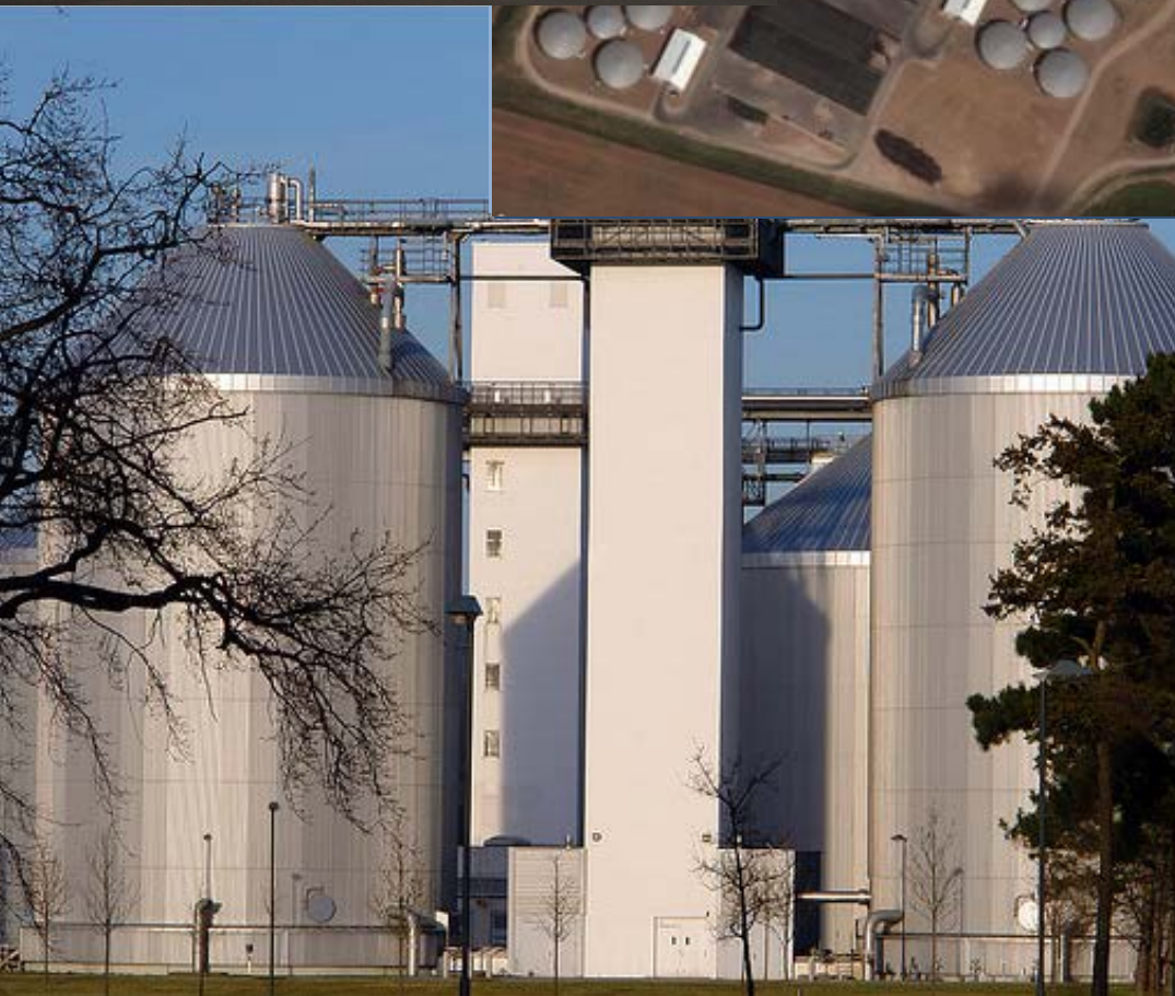
ETE Waßmannsdorf – Berlinwasser
