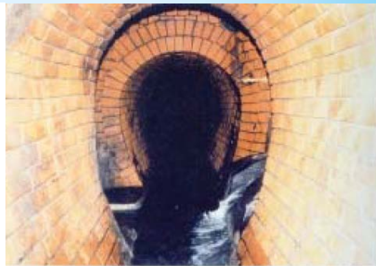
Figura 2: Coletor de esgoto em Kanda Japão Fonte: JSWA (2003)
