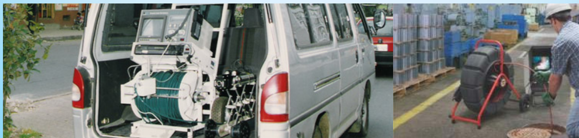
Figura 6: Filmagem de redes coletoras de esgoto
