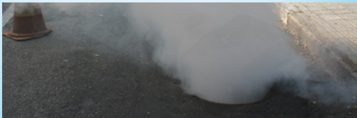
Figura 7: Execução de teste de fumaça, vista da saída da fumaça no poço de visita Fonte: Disponível em www.otec.com.br , acesso em 23/03/12
