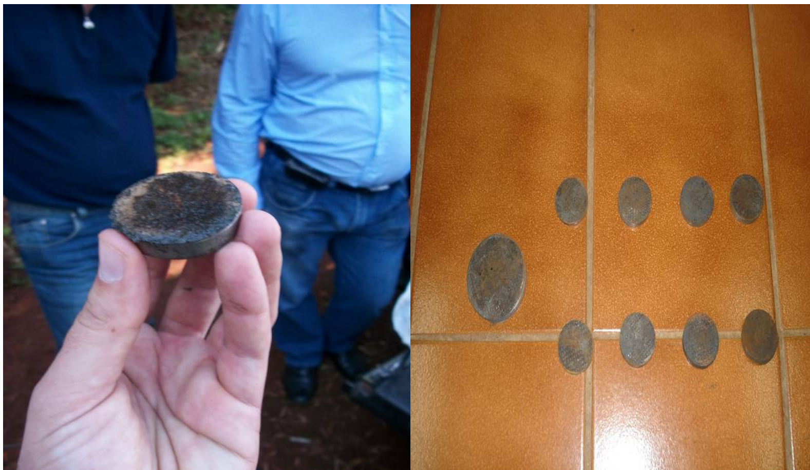
Imagem das paredes das tubulações perfuradas para implantação de ventosa em rede em carga.
