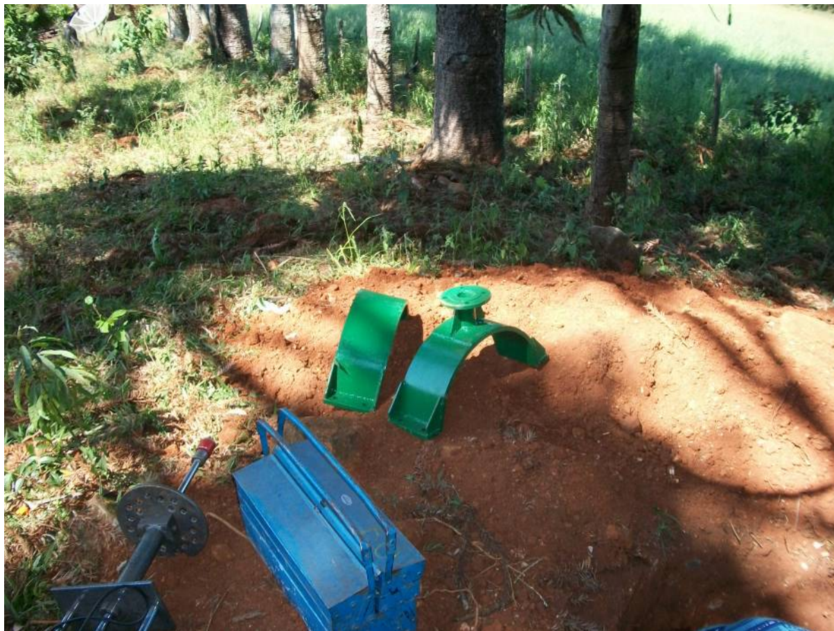
Imagem da abraçadeira especial bi-partida utilizada para a implantação das ventosas na AAB Rio Pato Branco.
