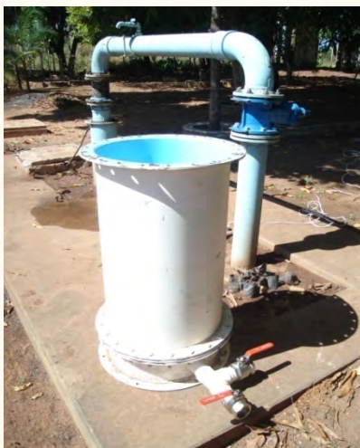
Fig. 10 – Montagem do filtro.
