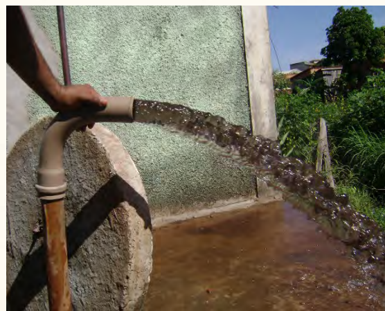
Fig. 19 – Descarga de rede.
