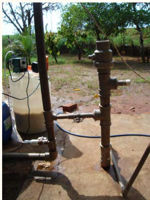
Fig. 12 – Equipamento de dissolução do cloro em tabletes.
