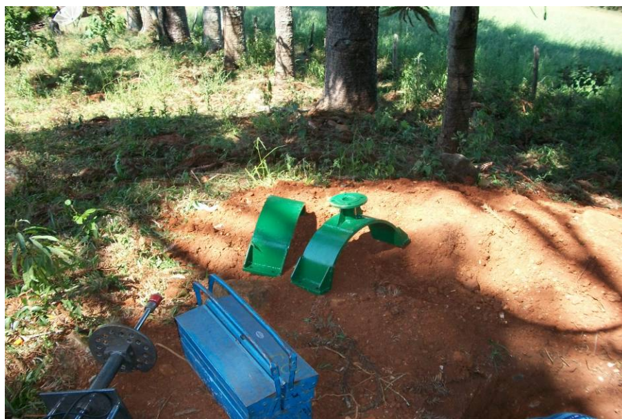
Figura 03: Imagem da abraçadeira especial bi-partida utilizada para a implantação das ventosas na AAB Rio Pato Branco. Fonte: Acervo do autor, 2010.
