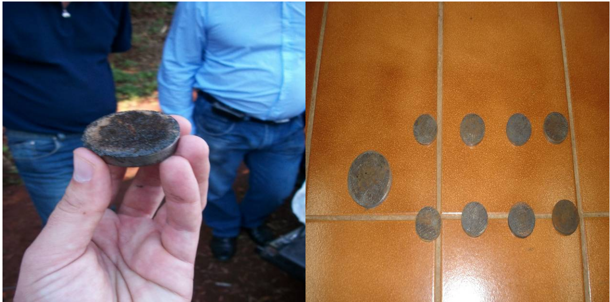
Figura 05: Imagem das paredes das tubulações perfuradas para implantação de ventosa em rede em carga. Fonte: Acervo do autor, 2010.
