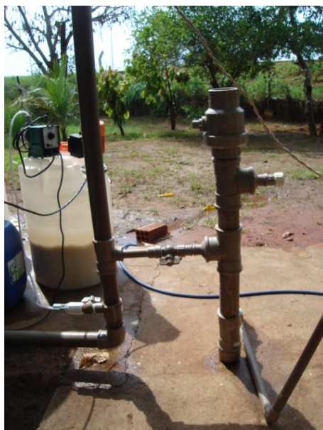
Figura 07 – Equipamento de dissolução do cloro em tabletes.
