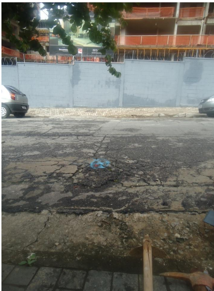
Foto 04: Locação de Ligações Inativas
