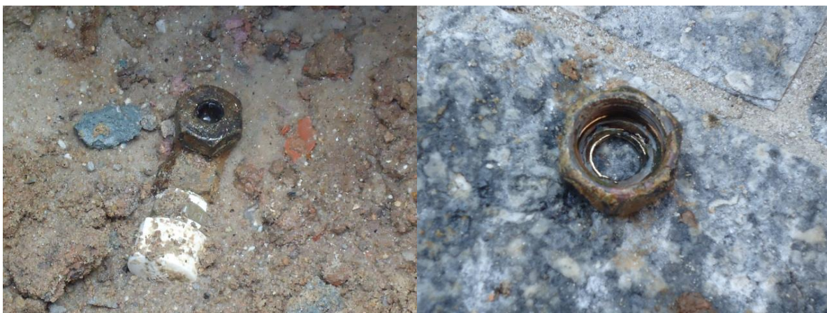
Foto 08: Locação de Ligações Inativas- Vazamentos Locados
