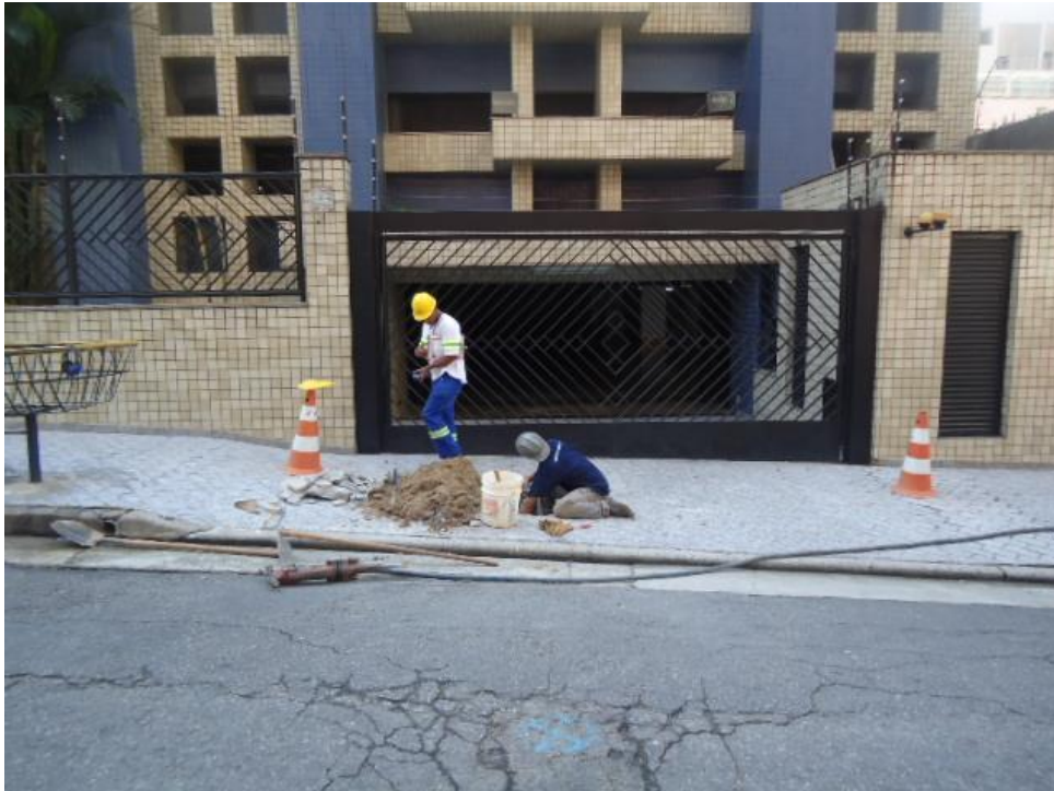
Foto 07: Locação de Ligações Inativas
