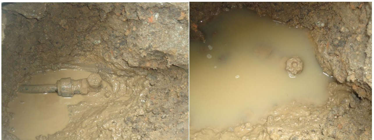
Foto 06: Locação de Ligações Inativas – Vazamentos Locados
