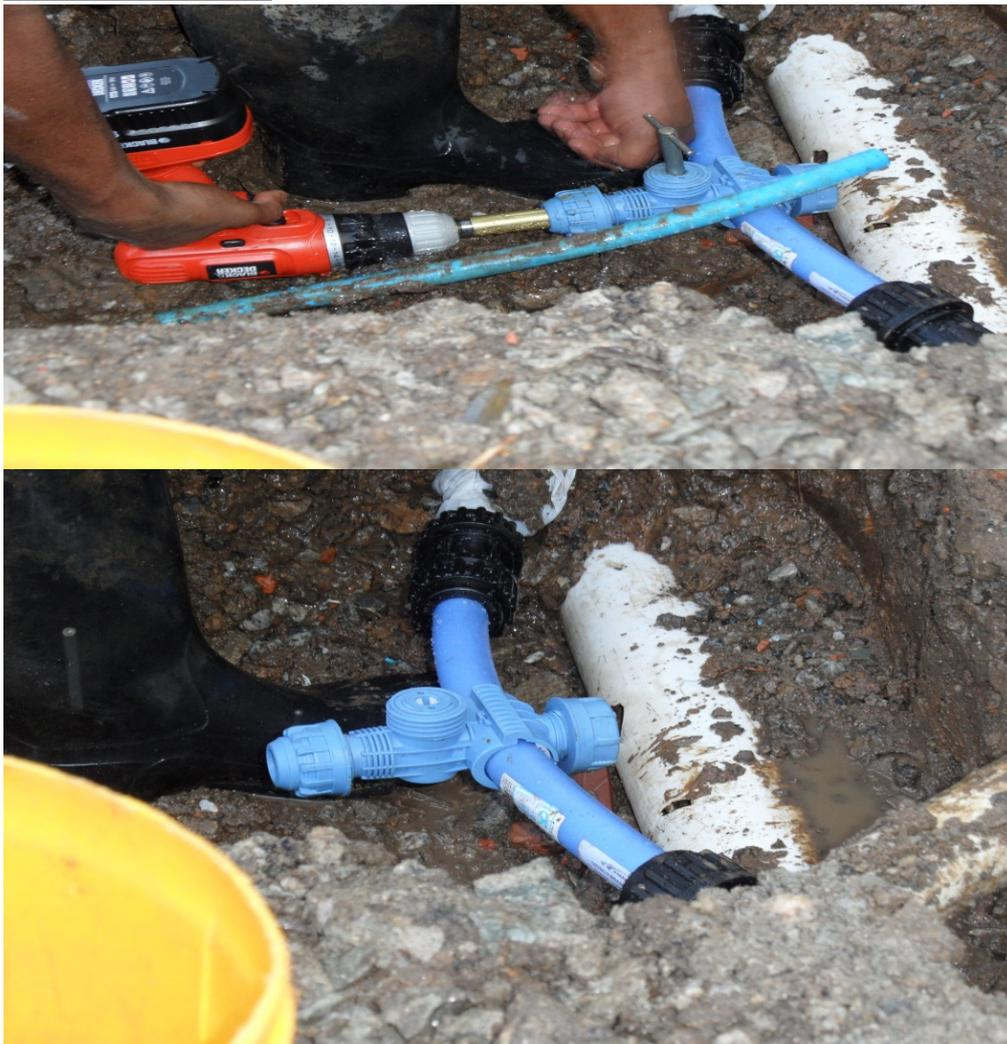
Fecha-se a válvula, efetua-se a limpeza no registro, colocar tampa/porca protetora de impurezas, realizar a colocação da tubulação de PEAD do ramal (20 mm), abrir a válvula e liberar água ao usuário.
