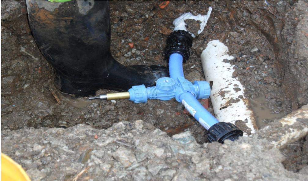
Para realização do furo de passagem do fluido para o novo ramal, o processo é realizado de maneira fácil e rápida. Não havendo a necessidade da desmontagem da peça.
