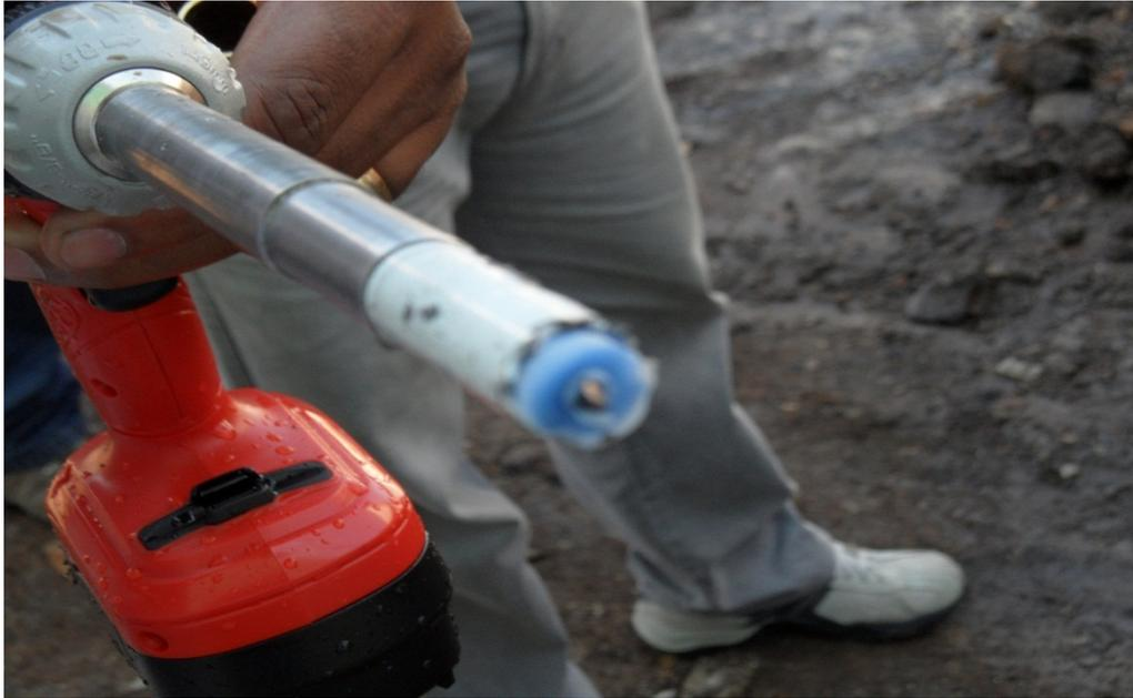
Após a realização do furo de passagem, realiza-se o fechamento da água, através da válvula incorporada na ULP.
