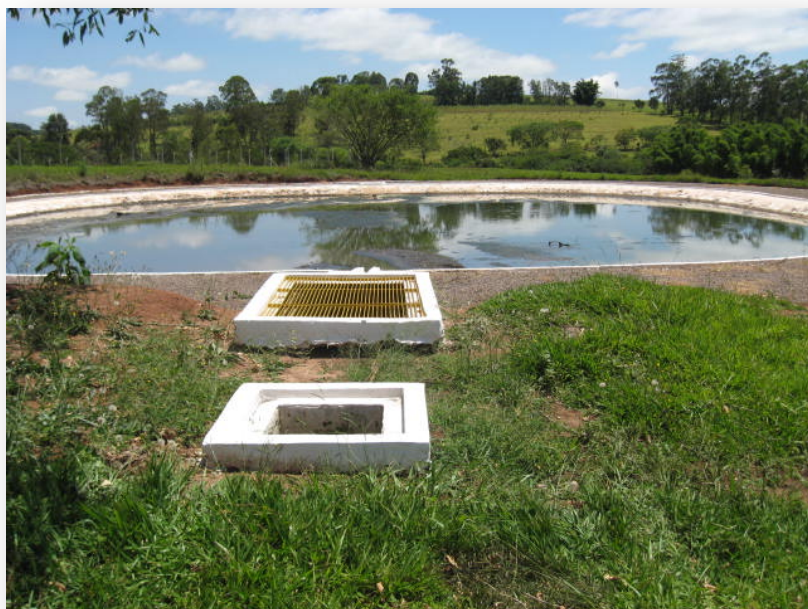
Lagoa anaeróbia e caixas de entrada sem armazenamento de resíduos antes da aplicação de auditoria housekeeping.
