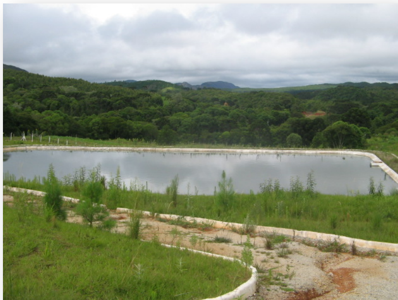
Lagoa facultativa e vias de acesso antes da aplicação de auditoria housekeeping.
