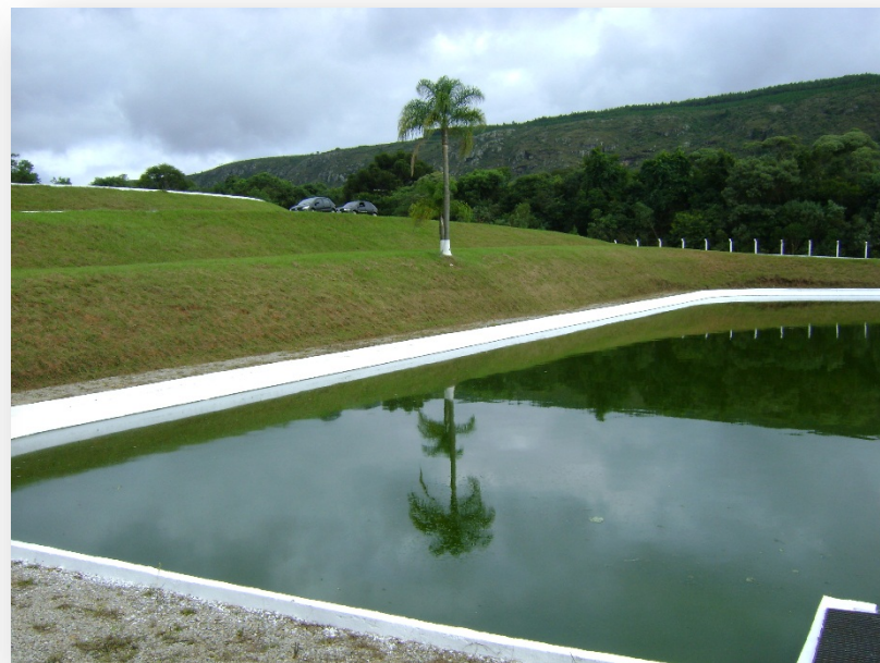
Lagoa facultativa e vias de acesso após aplicação de auditoria housekeeping.
