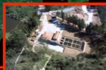
ETA Rib. Estiva
